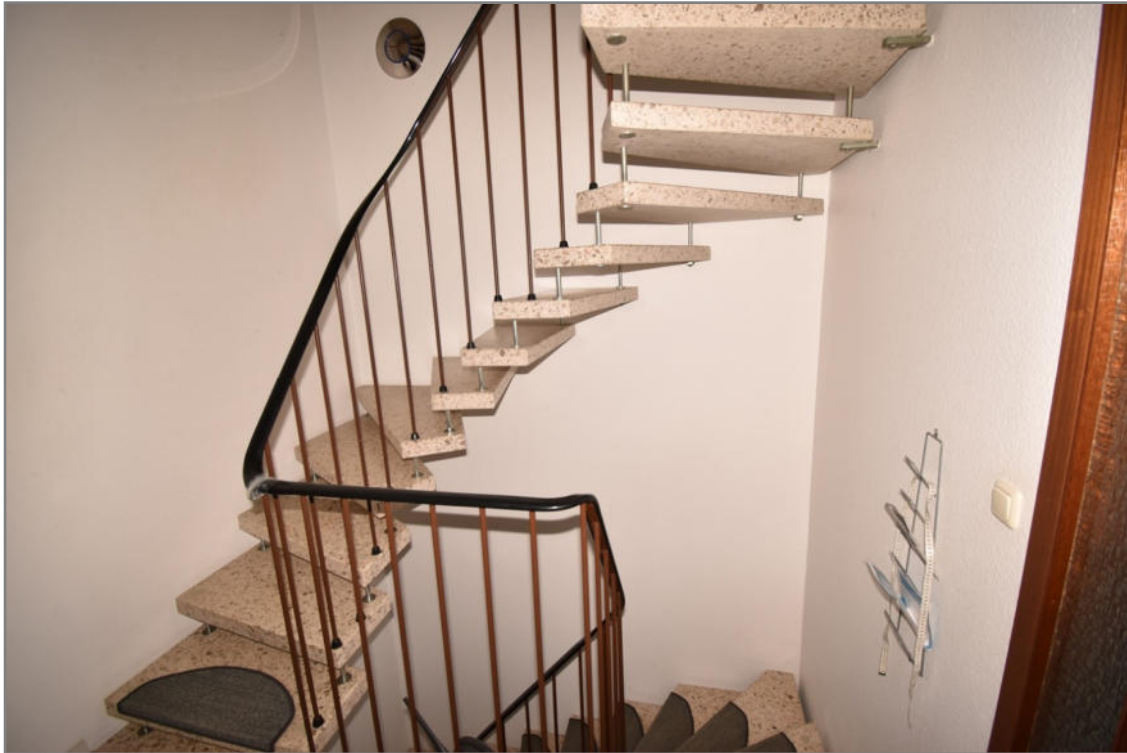
Hans-Fallada-Straße 197, Erdgeschoss, Treppe zum Keller- und zum Obergeschoss
