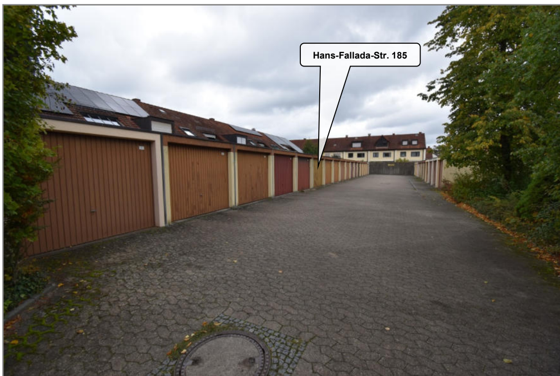
An der Hans-Fallada-Straße, Blick nach Osten in den Garagenhof
