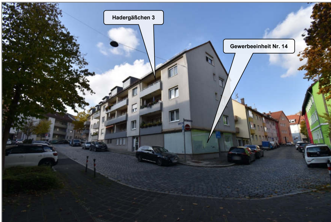
Blick über den Eckbereich Hadergäßchen (links) und Wöhrder Wollengasse (rechts) nach Nordwesten auf das Bewertungsobjekt
