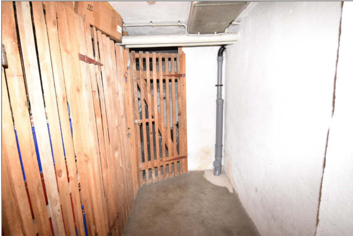
Kellergeschoss mit Kellerabteilen
