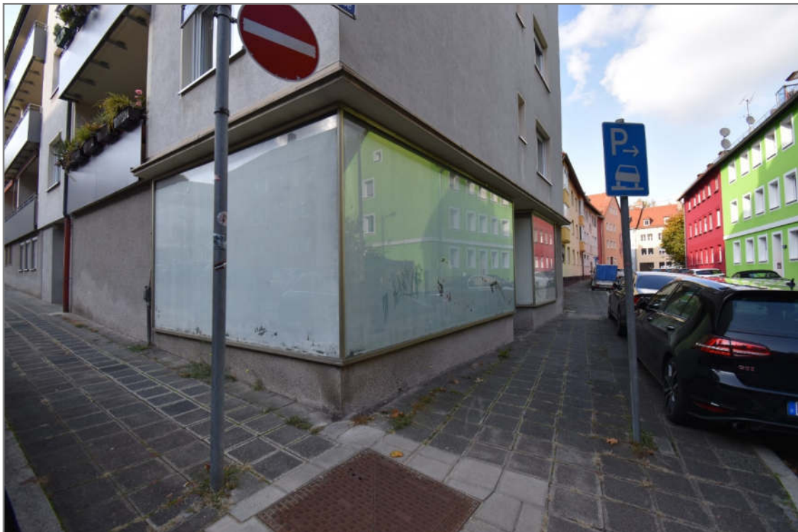
Blick von der Ecke Hadergäßchen / Wöhrder Wollengasse aus auf die Schaufenster und den Eingang der Gewerbeeinheit Nr. 14
