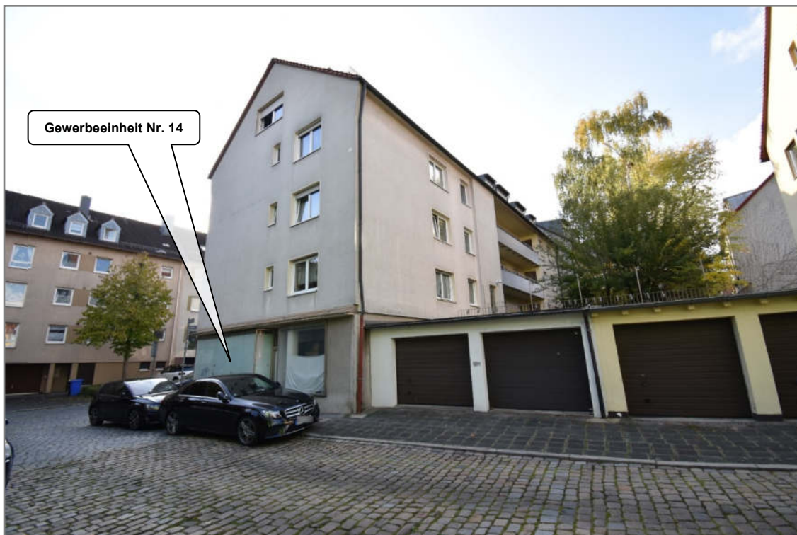
Blick über die Wöhrder Wollengasse nach Südwesten auf das Bewertungsobjekt
