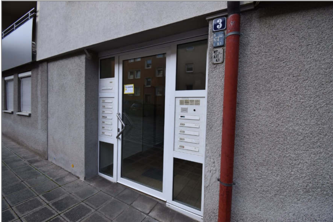
Hadergäßchen 3, Hauseingang im Kellergeschoss
