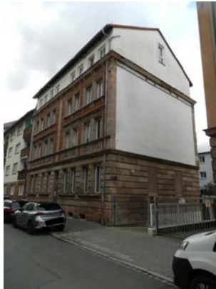
Ansicht von Süd-Ost
