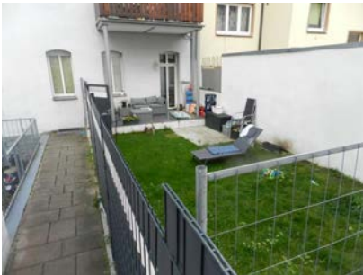
Ansicht von Norden; Whg. 1 und SNR
