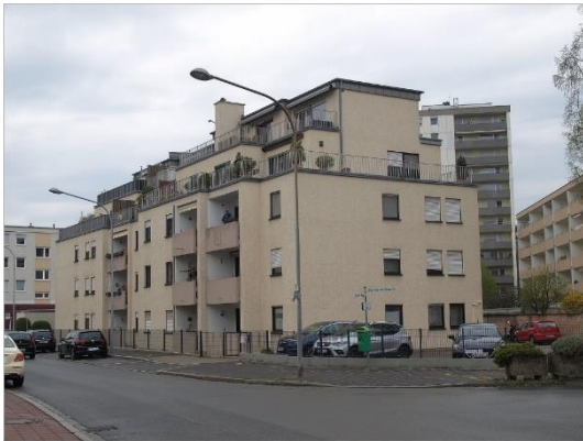
Ansicht von Osten
