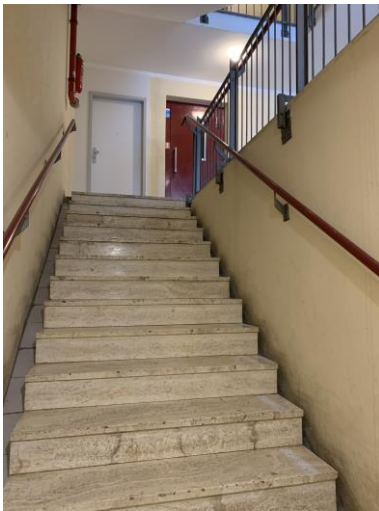
Treppe zum Kellergeschoss
