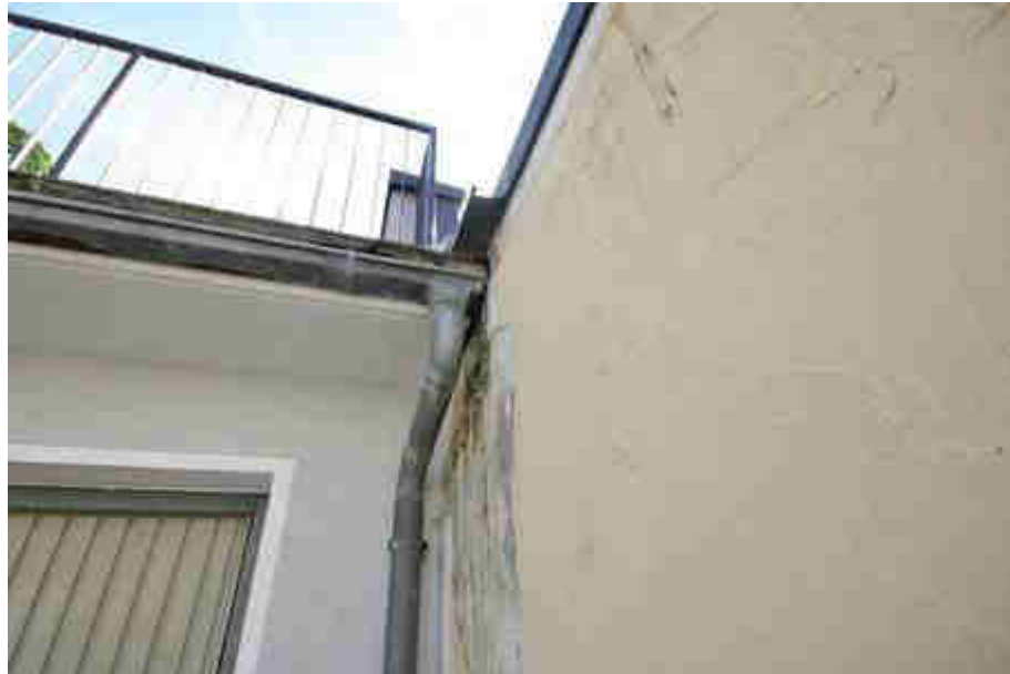
Blick auf Bereich des Feuchtigkeitsschadens an der nördlichen Außenwand des Garagengebäudes (vermutl. verursacht durch die Entwässerung der Dachterrasse/Garage des Nachbargebäudes)
