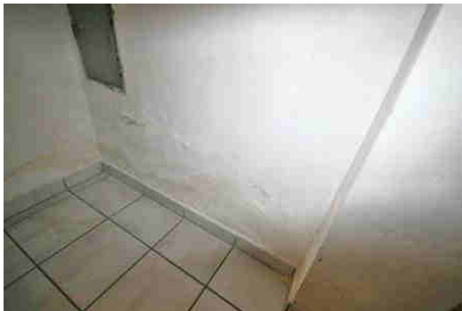
Blick auf Putz- und Feuchtigkeitsschäden und Ausblühungen im Sockelbereich einer aufgehenden Wand im KG
