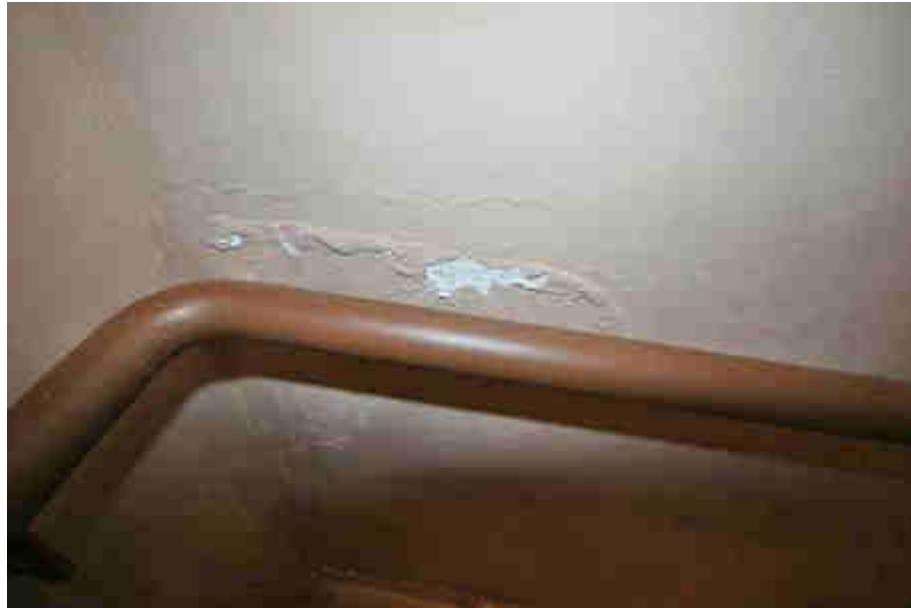
Blick auf Farbabplatzungen und Ausblühungen im Treppenabgang zum KG
