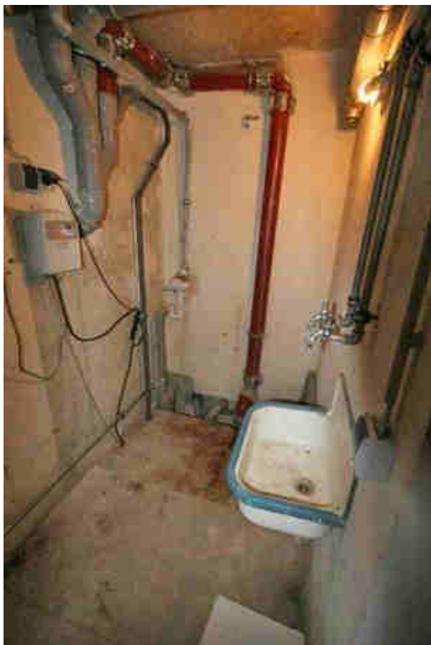
Blick auf Ausgussbecken und Hebeanlage für Toilettenanlagen Damen/Herren und Behinderten-WC im KG
