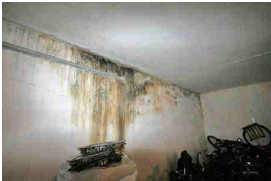
Blick auf Feuchtigkeits- und Schimmelschäden im Bereich der Decke / nördlichen Außenwand des Garagengebäudes
