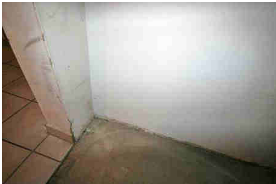
Blick auf Putz- und Feuchtigkeitsschäden im Sockelbereich einer aufgehenden Wand im KG
