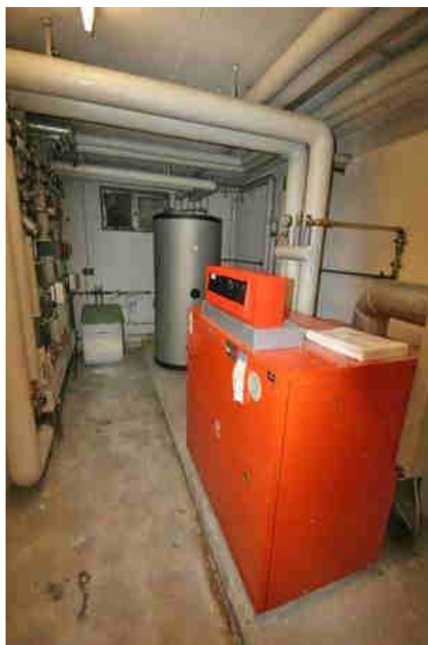
Blick in Heizungsraum im KG mit Heizkessel für Gasfeuerung
