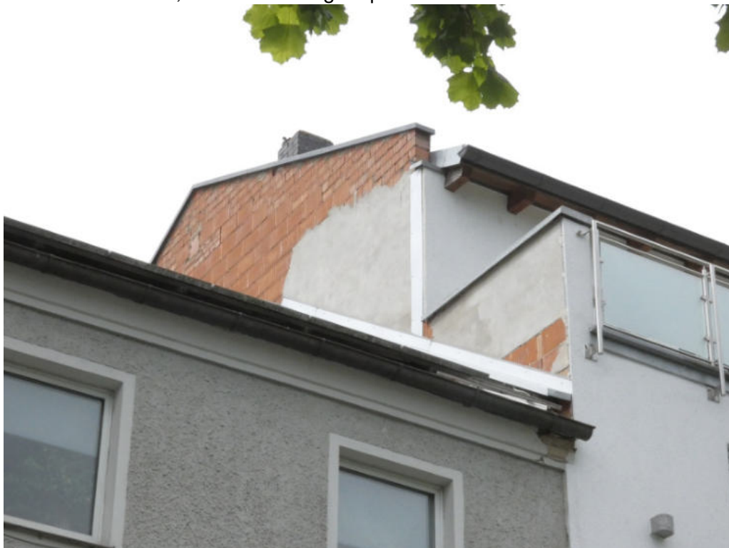
Bild 4: Giebel links, noch nicht fertig verputzt.
