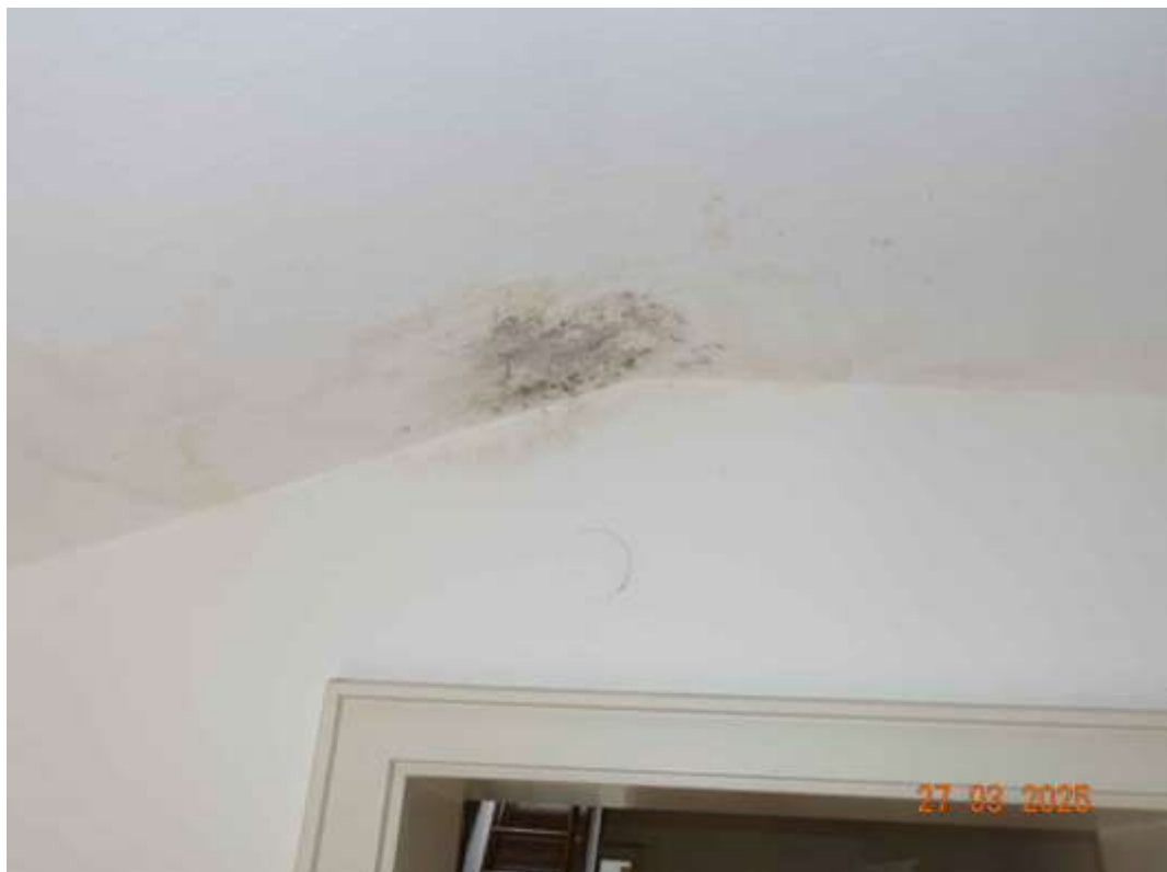
Abbildung 22: Anzeichen eindringender Feuchte im Windfang im OG
