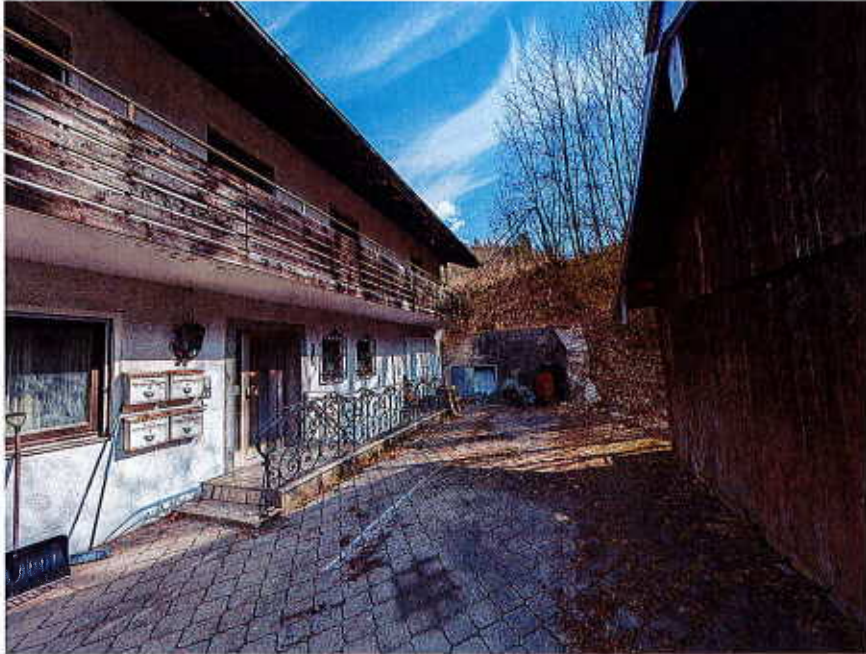
Ansicht Südosten -Eingang-
