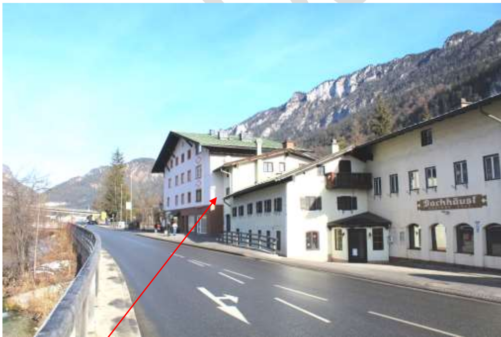
Abb. 4: Südansicht Hauptstr. 56, Bundesstraße B 20, Umgebung
