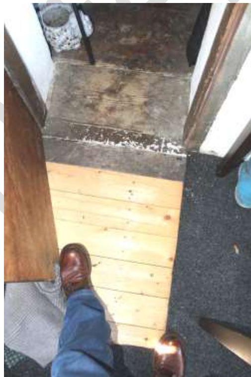
Abb. 19d: Erneuerte Balkonbodenbretter – Teilbereich
