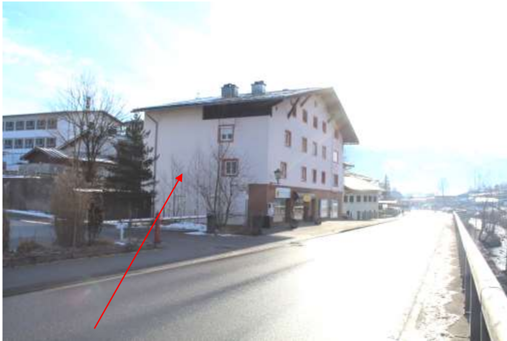
Abb. 3: Nordansicht Hauptstr. 56, Bundesstraße B 20, Umgebung
