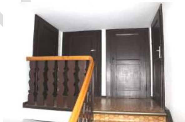
Abb. 15: Zugang zu Speicherräumen
