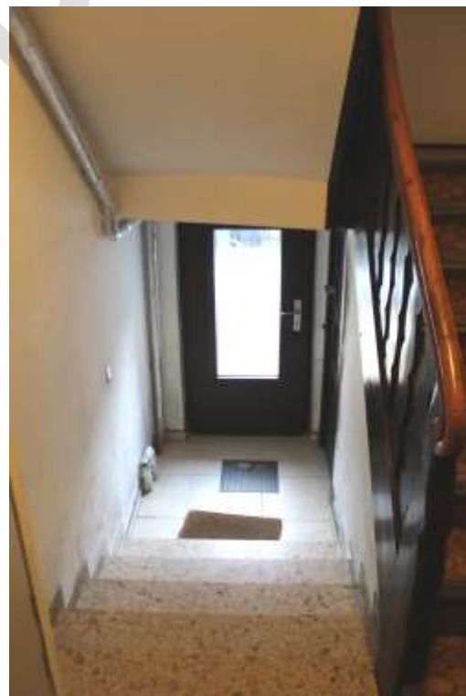
Abb. 12a: Treppenhaus, Hoftür
