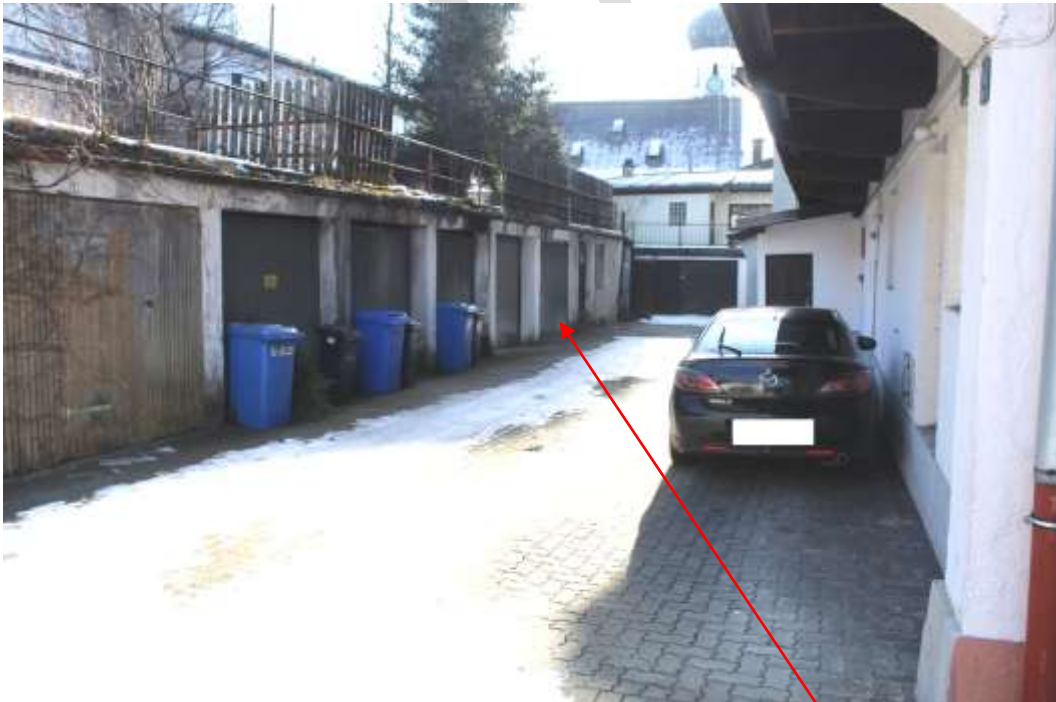
Abb. 6: Hof, Zufahrt zum Garagentrakt, Blickrichtung Süden, Garage Nr. 5
