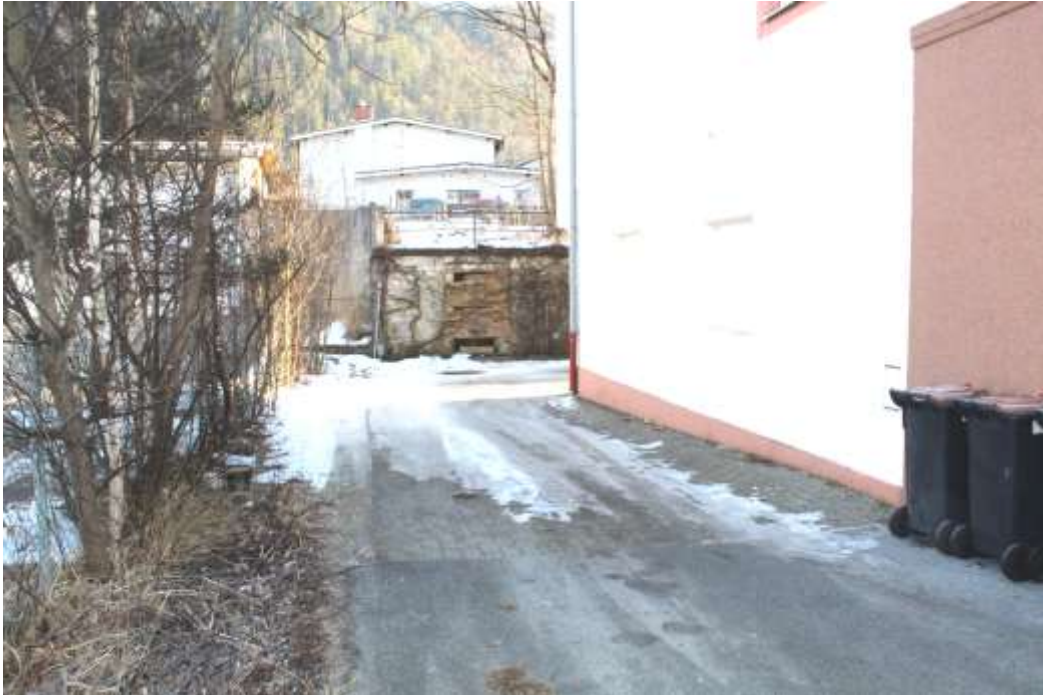
Abb. 5: Zufahrt auf der Gebäudenordseite
