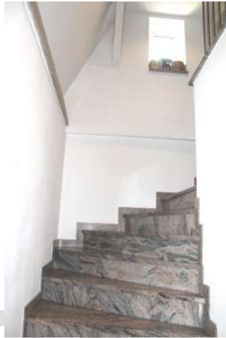
Abb. 35: Treppe ins DG
