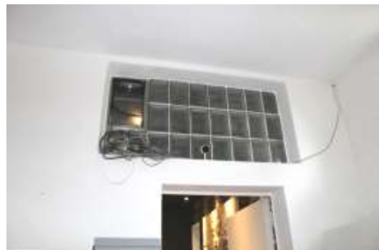
Abb. 10b: Treppenhaus - Oberlicht mit Glasbausteinen
