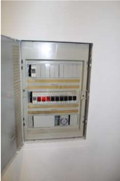
Abb. 17: Sicherungskasten EG
