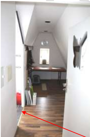
Abb. 40: Raum mit WC - DG
