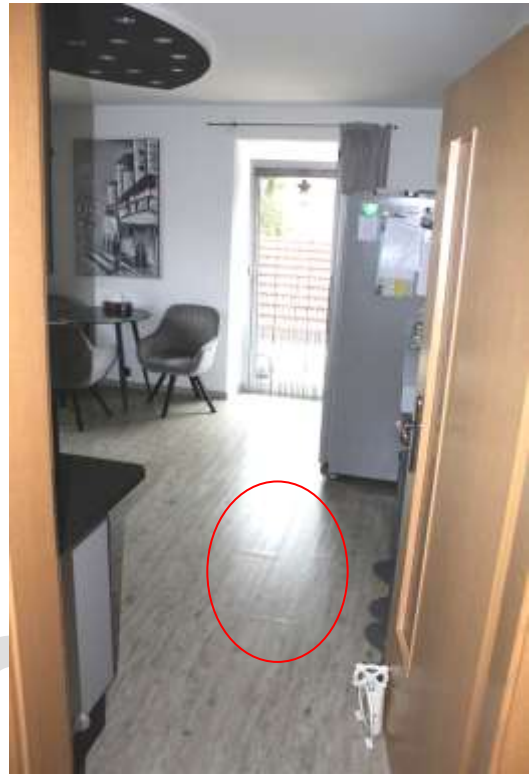
Abb. 26: Küche OG, Bodenzustand (beispielh.)
