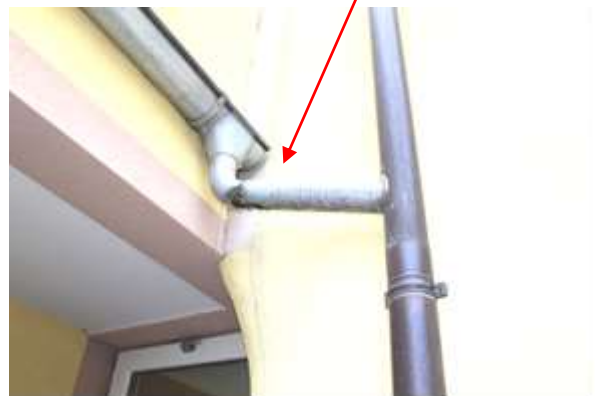
Abb. 7a: Kontaktkorrosion
