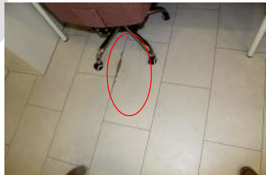
Abb. 18b: Bodenabnutzung (beispielh.)
