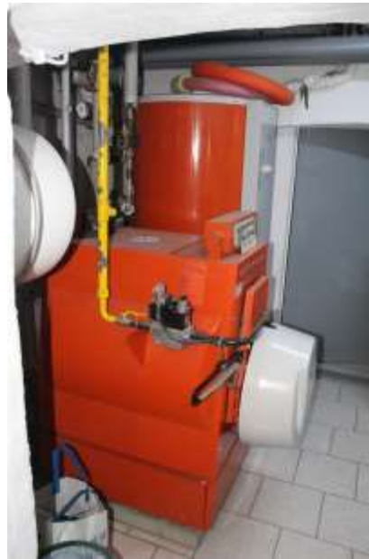
Abb. 51: KG - Gas-Heizung
