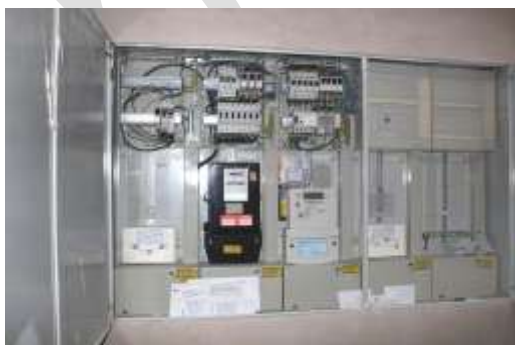
Abb. 22: Sicherungskasten Treppenhaus
