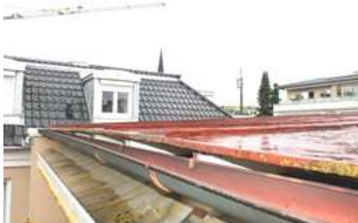
Abb. 34a: Blechdach - Westseite
