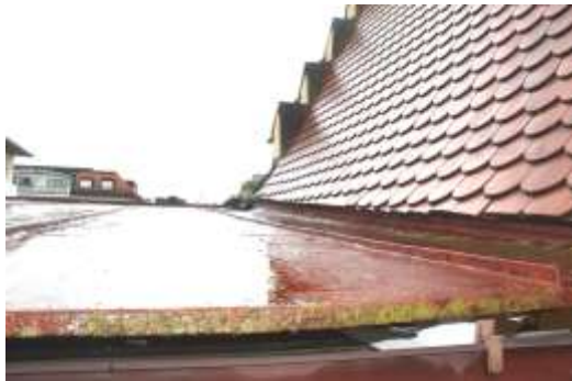
Abb. 34: Blechdach über Wohnzimmer
