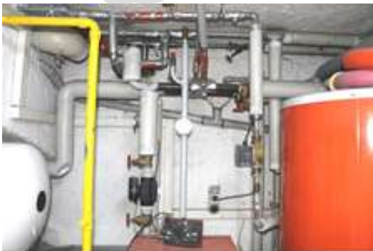
Abb. 50: KG- Rohrisolierungen
