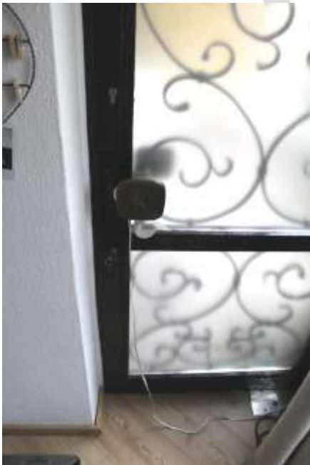
Abb. 19a: Nebeneingangstür, einfachverglast und beklebt
