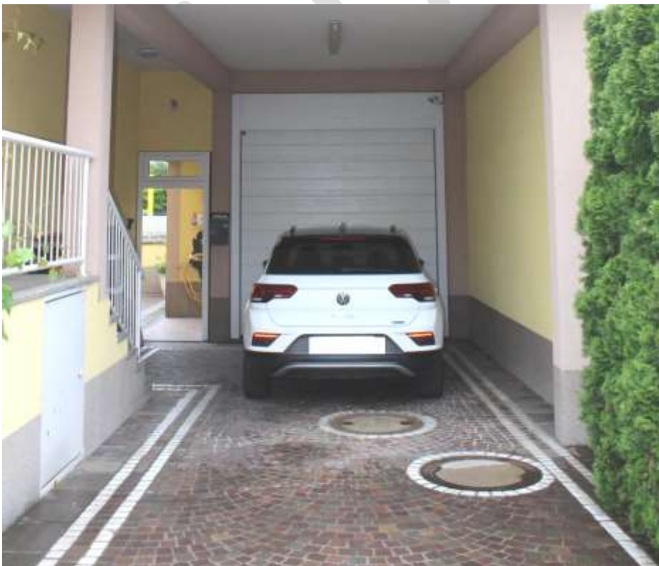
Abb. 4: Überdachter Zufahrtbereich Garage, Hofeingang
