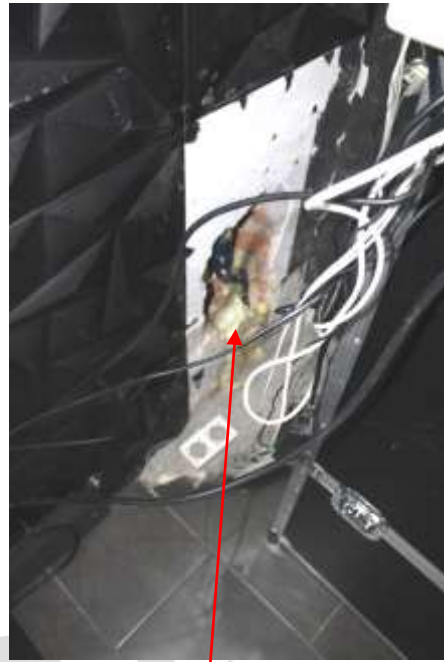
Abb. 12b: Offene Reparaturstelle hinter Ladentür
