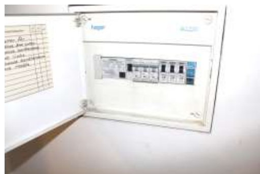
Abb. 41: Sicherungskasten DG
