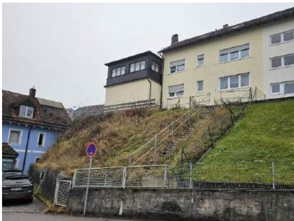
Ansicht von Nordwesten/ von Bruckdorfer Str.
