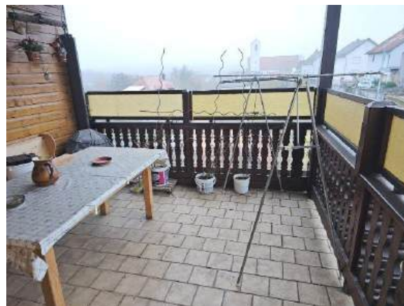
Freisitz oberhalb Garagen
