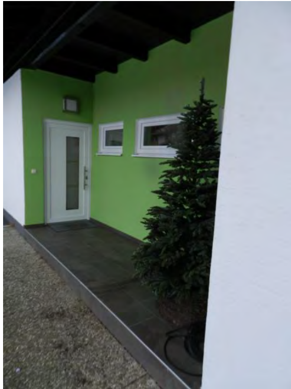
Hauseingang in Nordfassade
