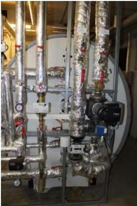
**Abb. 15b:** Heizraum – Rohrinsolierung
