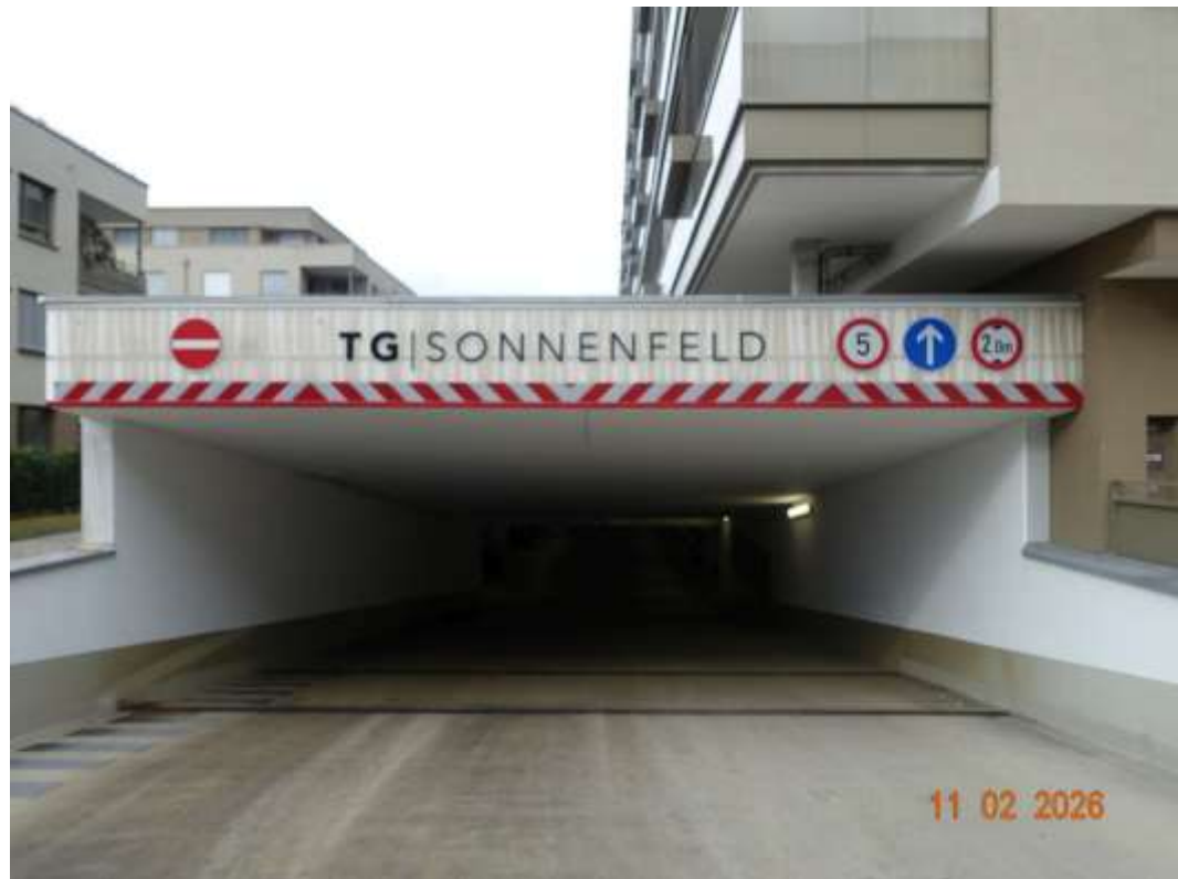
Abbildung 7: Zweispurige Zufahrt in die Tiefgarage
