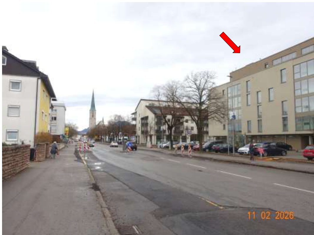
Abbildung 2: Ansicht der Münchener Straße in Freilassing mit Gebäudeteil B
