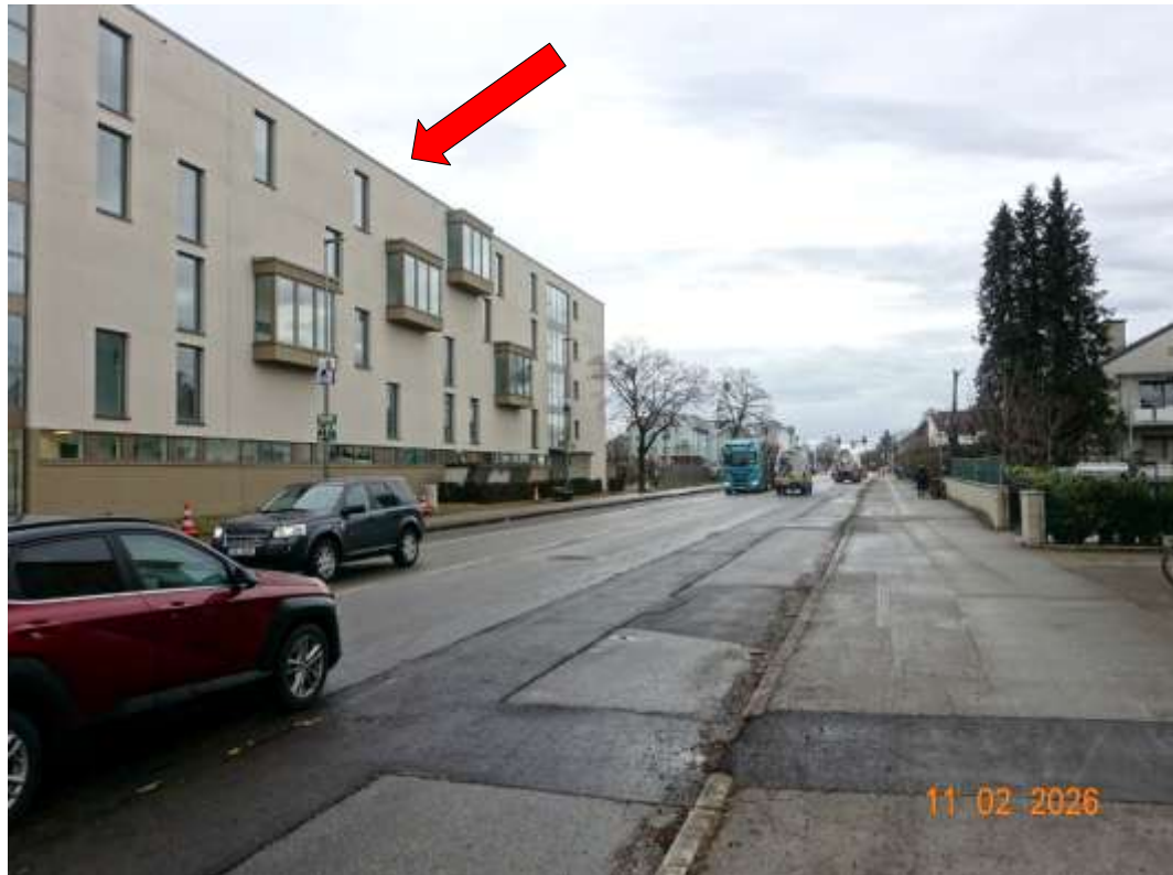
Abbildung 1: Ansicht der Münchener Straße in Freilassing mit Lage des Gebäudes A
