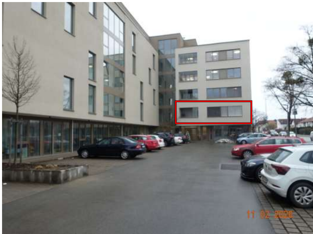
Abbildung 4: Lage von Sondereigentum Nr. 20 im 1. OG vor den Parkflächen
