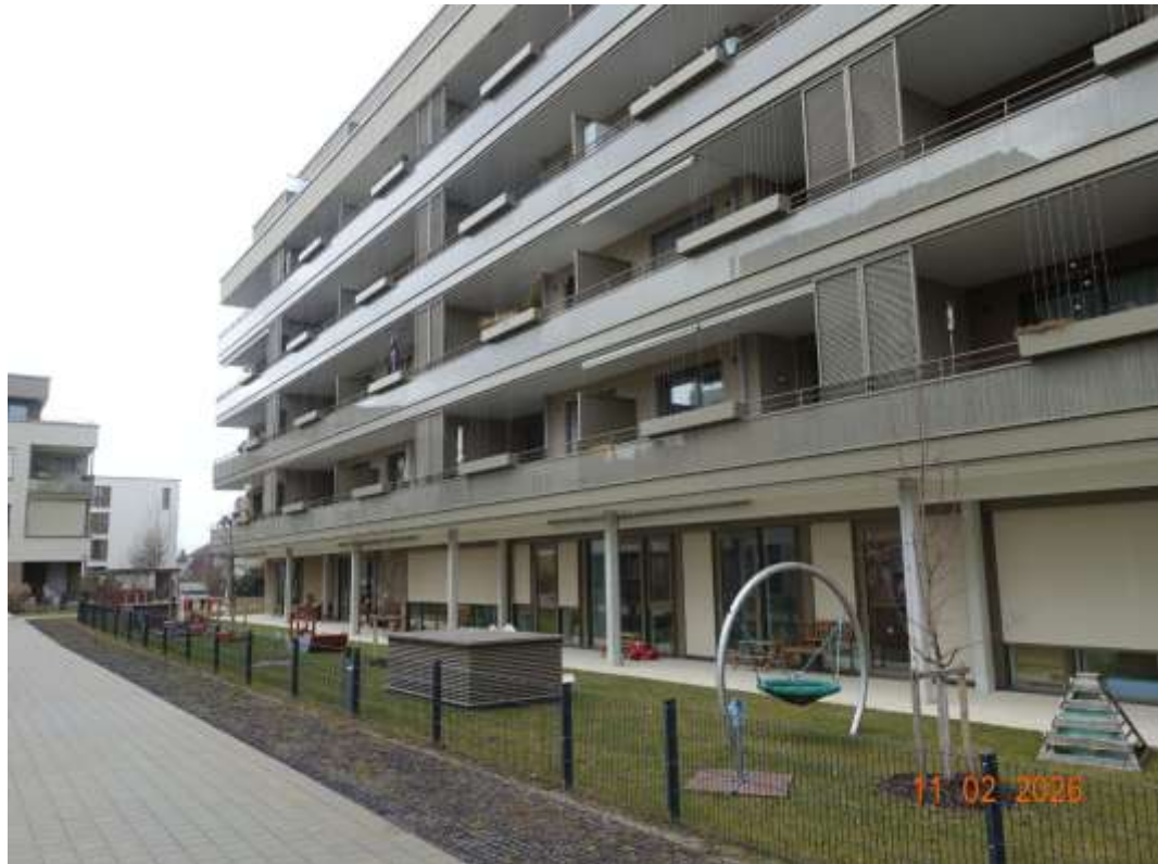
Abbildung 5: Südliche Rückseite von Gebäudeteil A (Kindergarten im EG)
