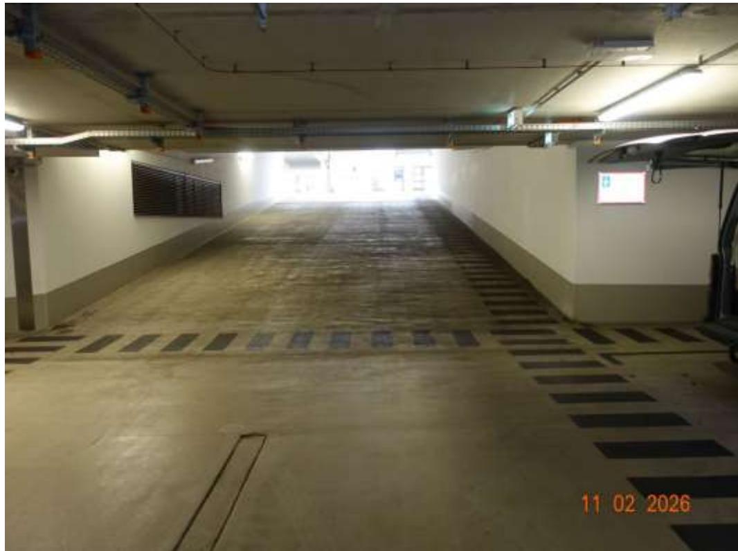
Abbildung 11: Zufahrt zur Tiefgarage, Kurzparkplätze ohne Zufahrtsbeschränkung
