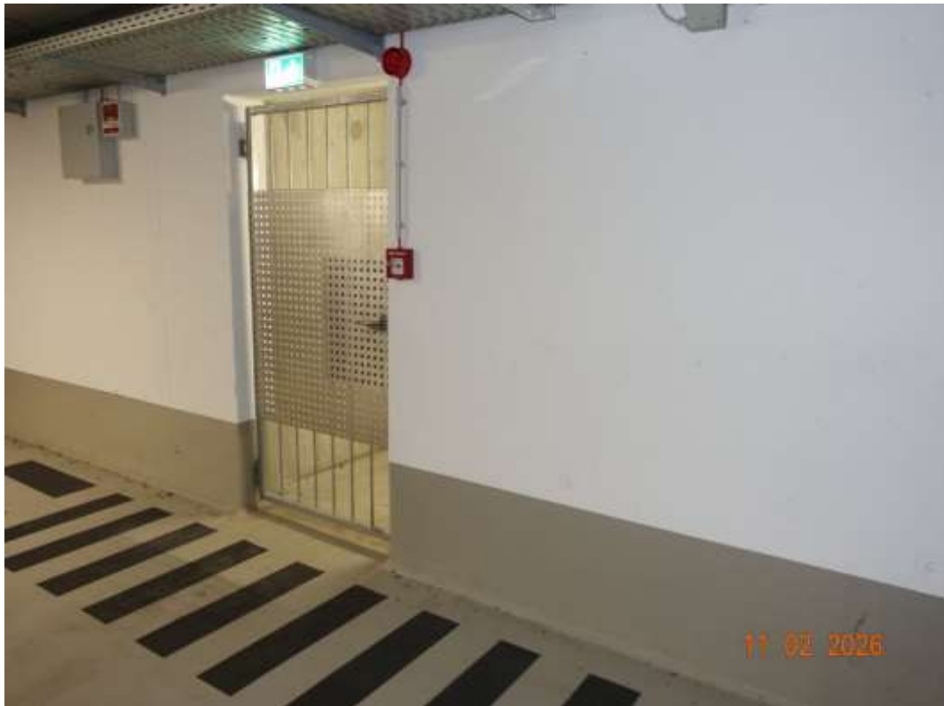
Abbildung 9: Notausgänge aus der Tiefgarage nahe dem Beschlagnahmeobjekt
