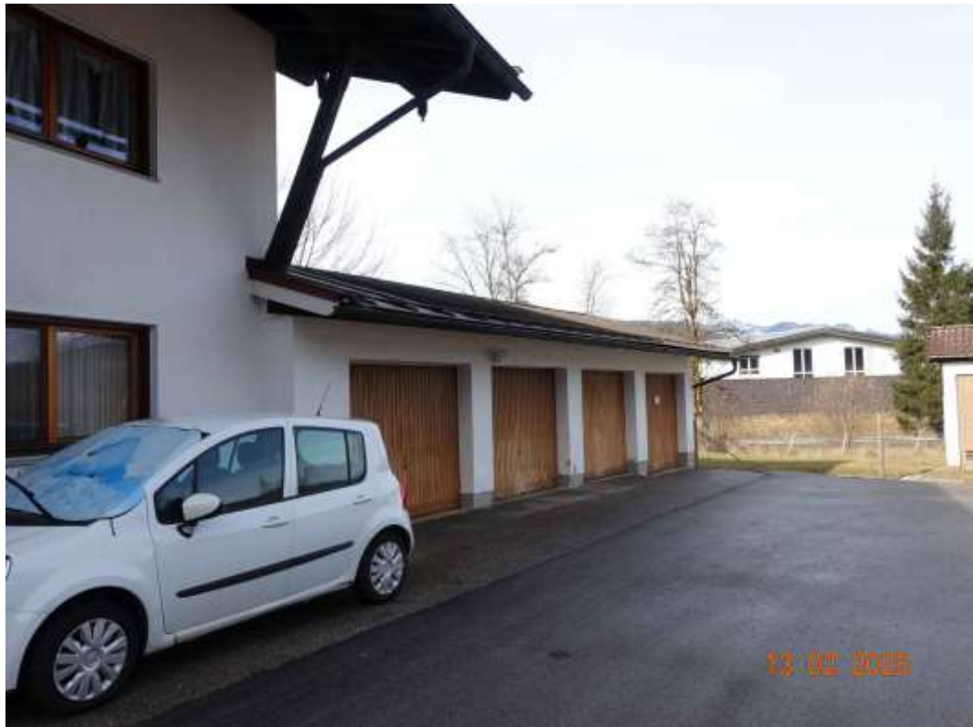
Abbildung 3: Nordseite des Wohnhausanbaus mit vier Garagen
