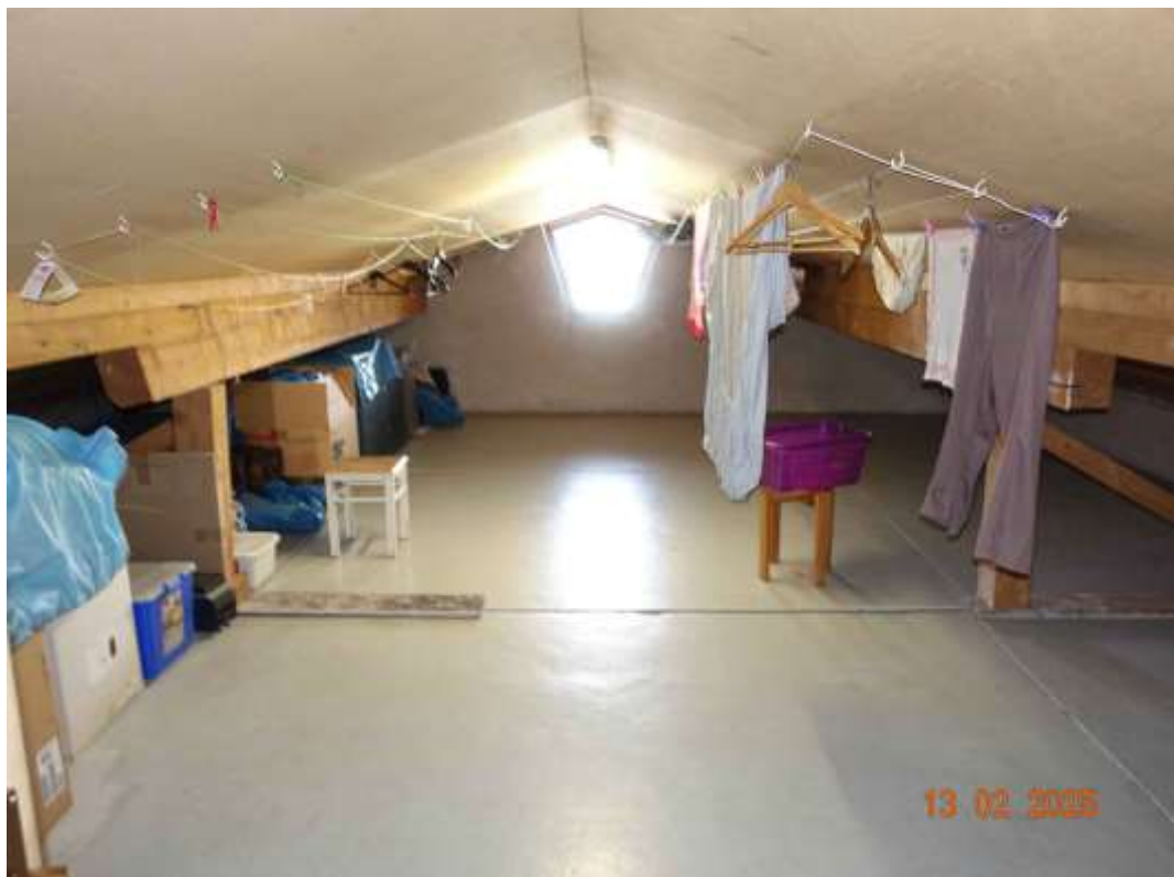
Abbildung 38: Dachbodenraum im Hausanbau
