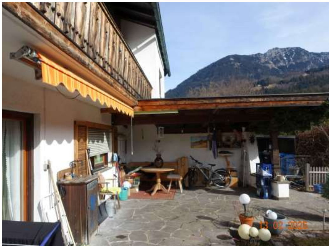
Abbildung 6: Südwestseite des Wohnhauses mit angebautem Freisitz
