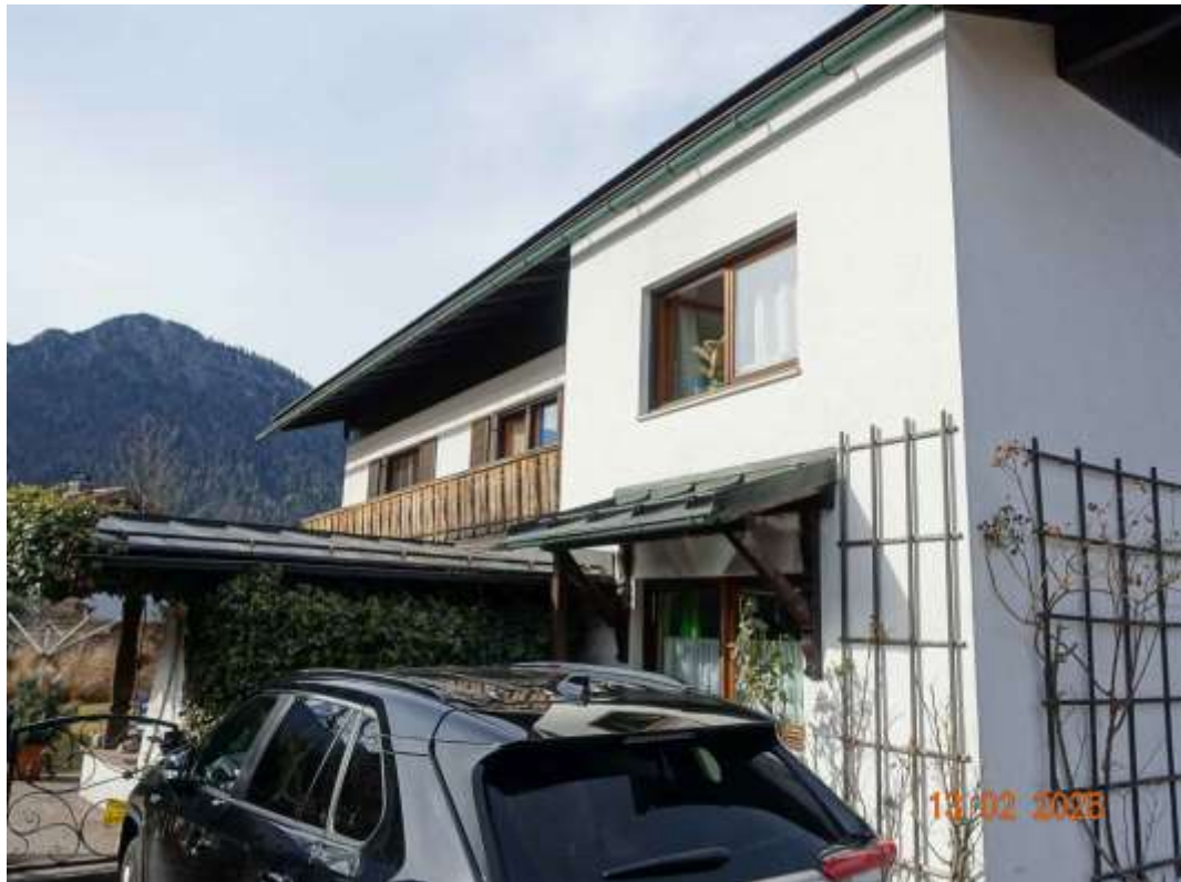
Abbildung 5: Südseite des Wohnhauses mit angebautem Freisitz
