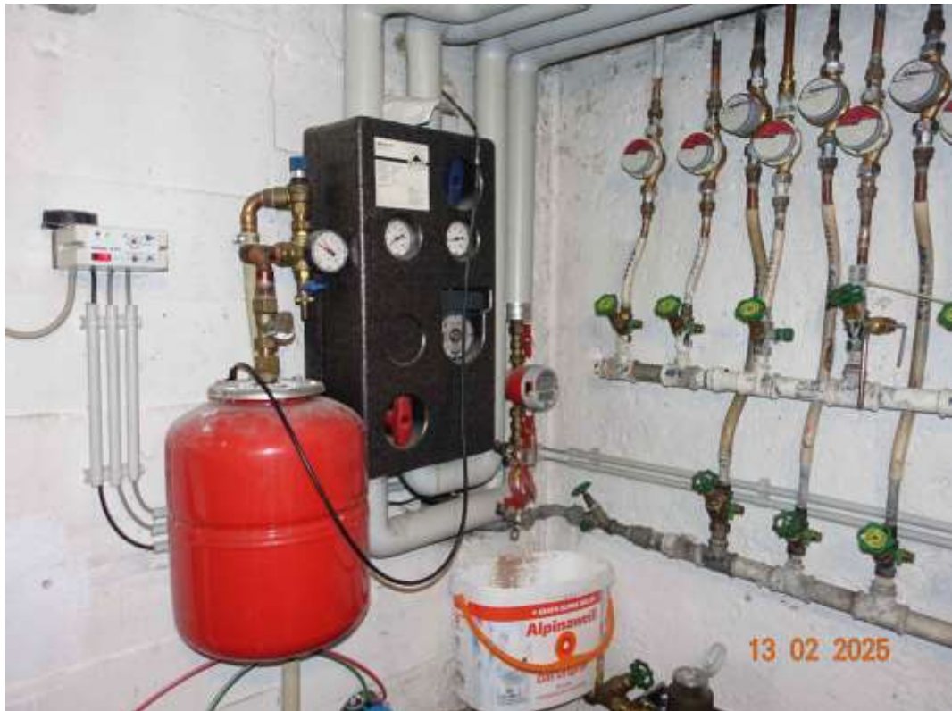
Abbildung 41: Beispiel der Rohinstallation im Wohnhaus
