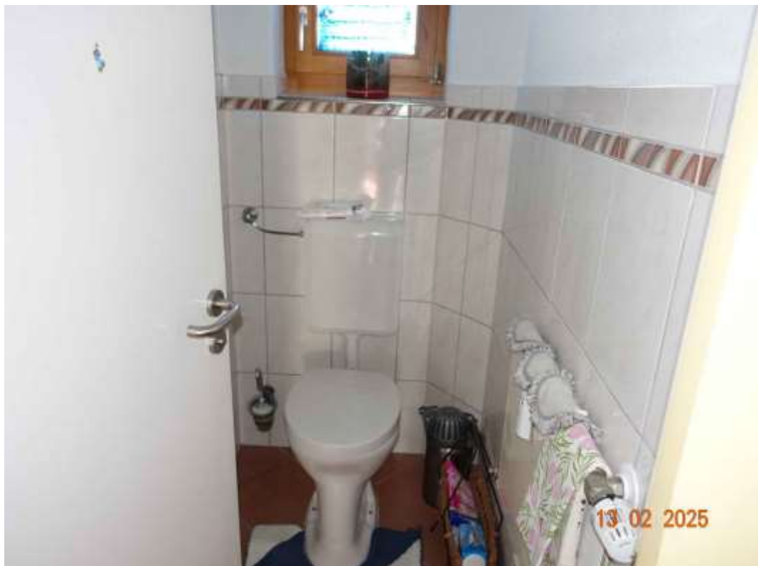
Abbildung 18: Abgetrenntes WC mit Fenster im Wohnhaus
