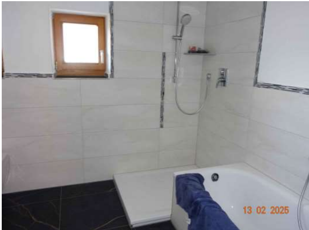
Abbildung 25: Bad in der Wohnung im OG des Wohnhauses
