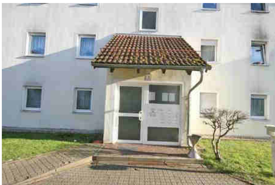
Blick auf Hauszugang HsNr. 8
