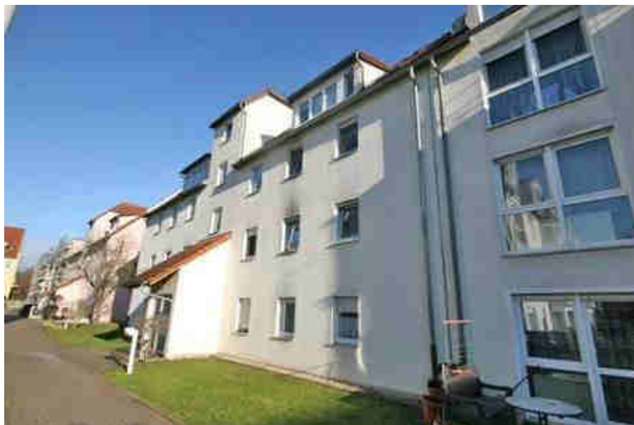
Blick von Süden auf Gebäude HsNr. 8, rechts im Bild angrenzend Gebäude HsNr. 6
