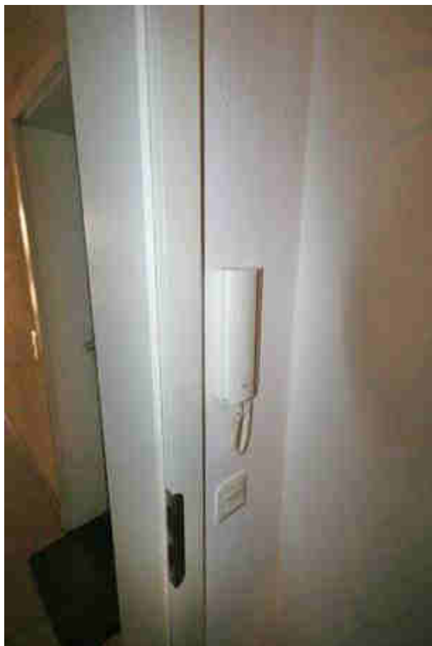
Blick auf Türzarge der Wohnungseingangs- türe und kombinierte Klingel-, Gegensprech- und Türöffnungsanlage
