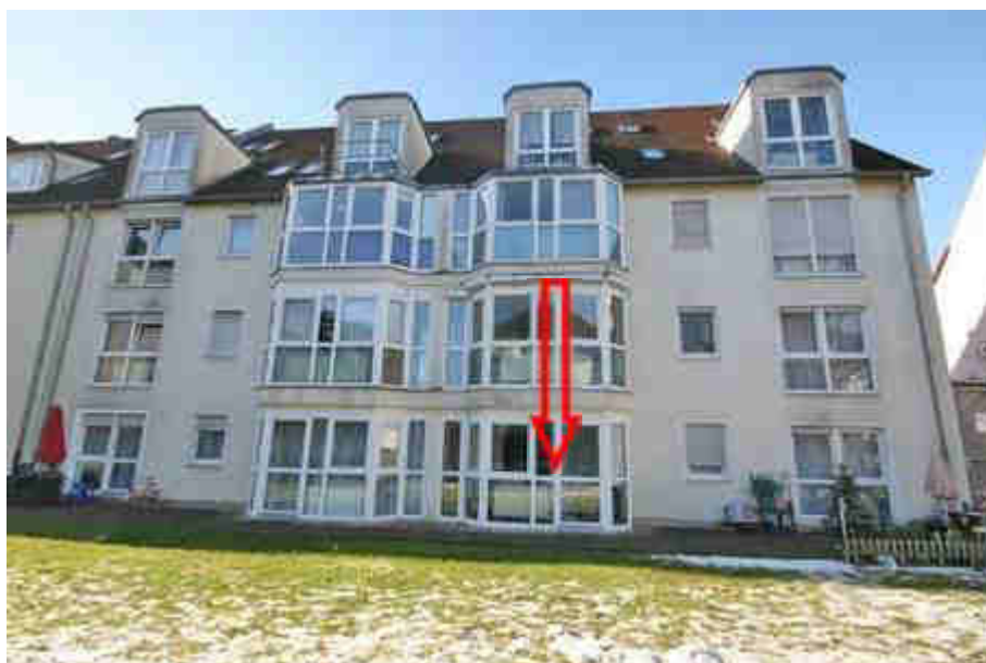
Blick von Nordosten auf Gebäude HsNr. 8
