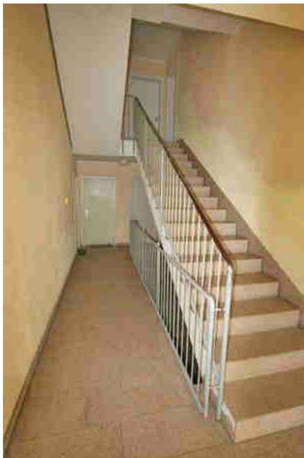
Blick in Treppenhaus
