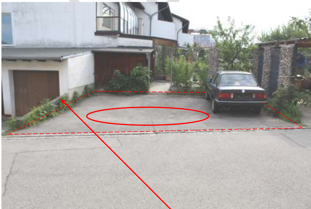
Abb. 6: FlNr. 868/25 – Parkplatz, fehlende Absturzsicherung, Mulde im Belag Seite 66 von 82
