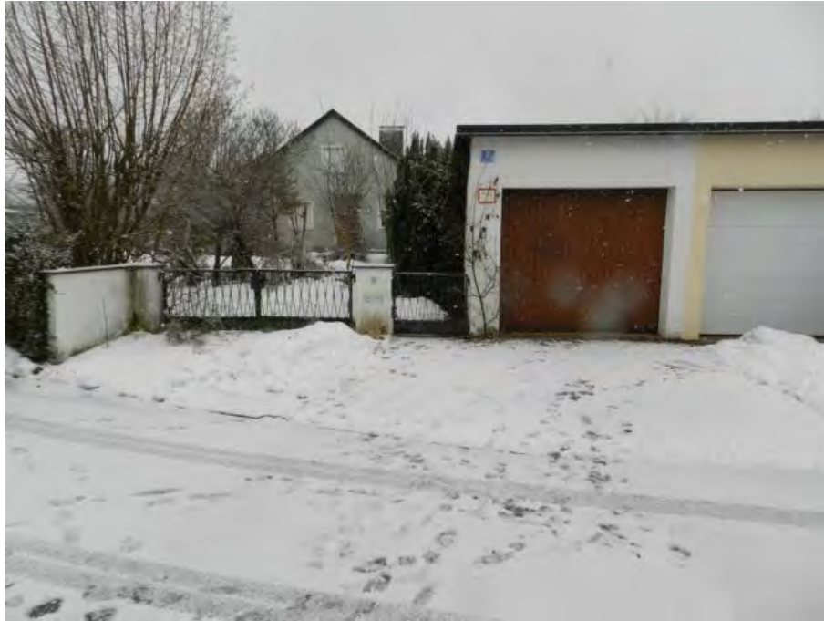
Eingangsbereich; Ostgiebel; Garage
