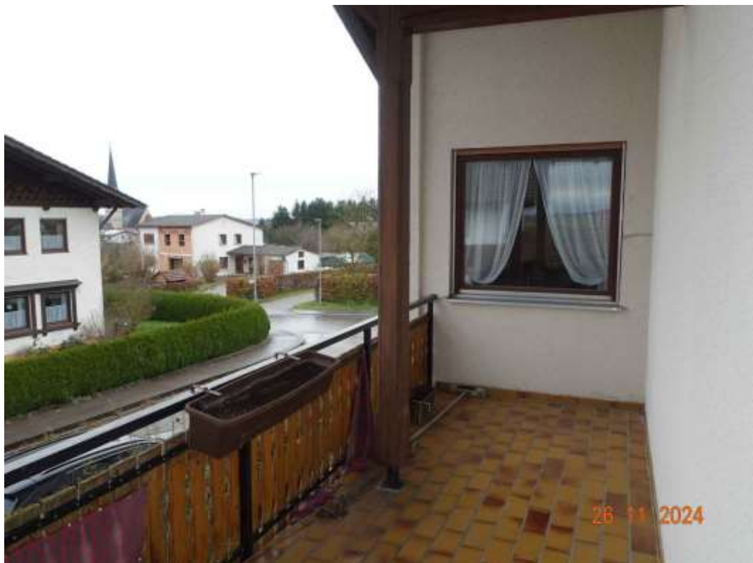
Abbildung 28: Balkon auf der Westseite
