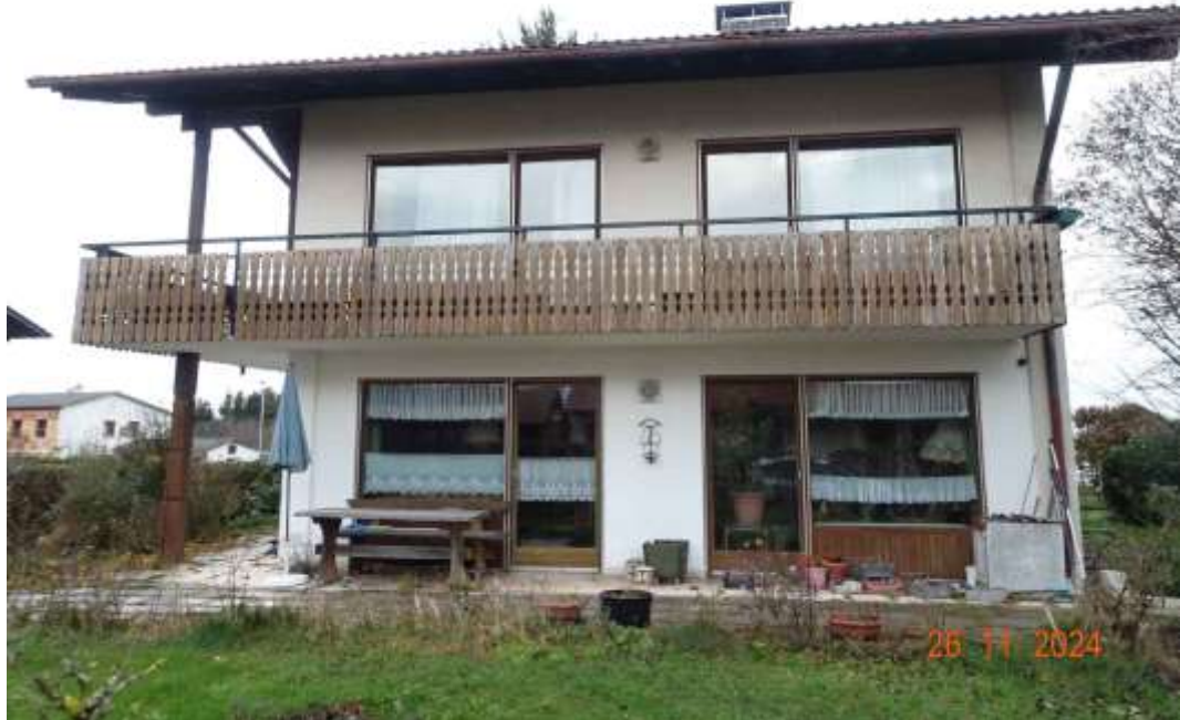
Abbildung 33: Ansicht von Süden aus Sicht der Garage
