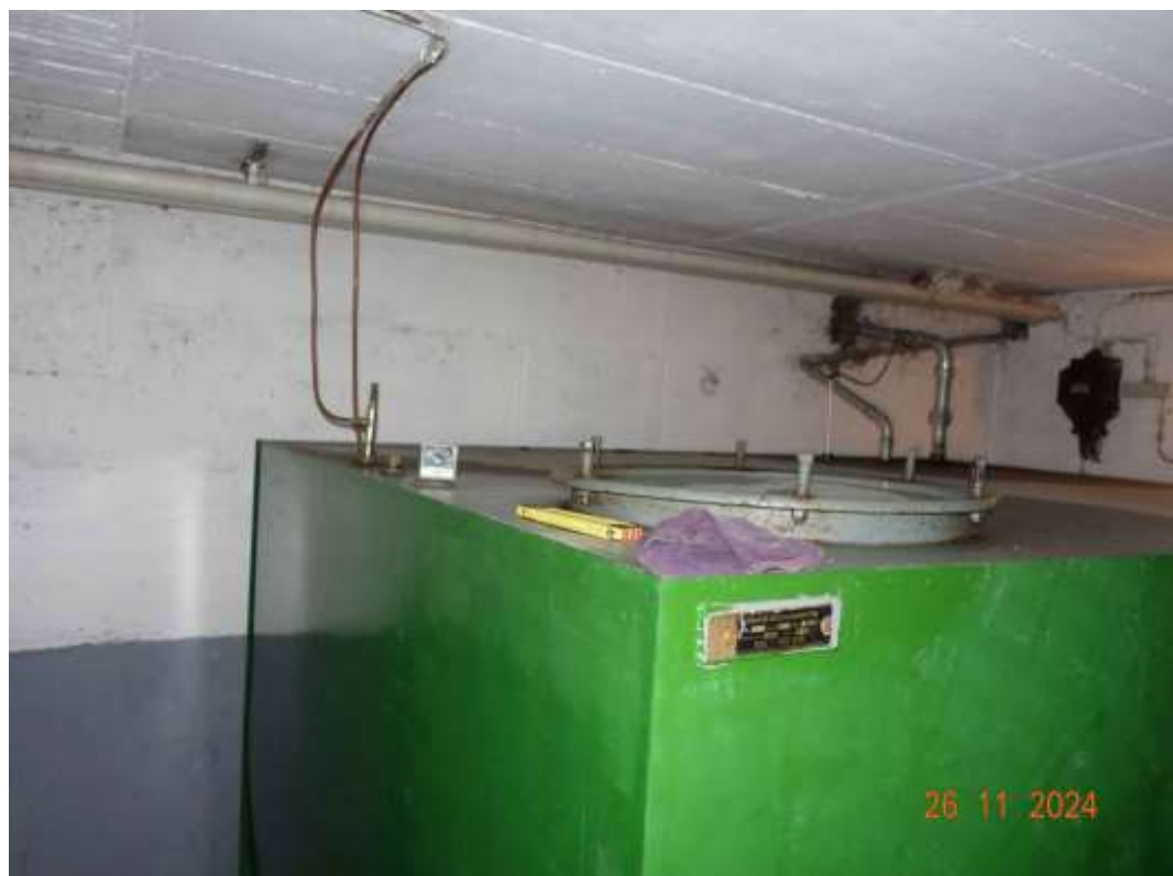
Abbildung 12: Kellergeschweißter Stahltank
