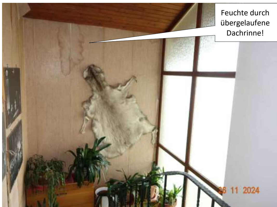
Abbildung 22: Lichtband vom Hauseingangsbereich bis zum Dach
