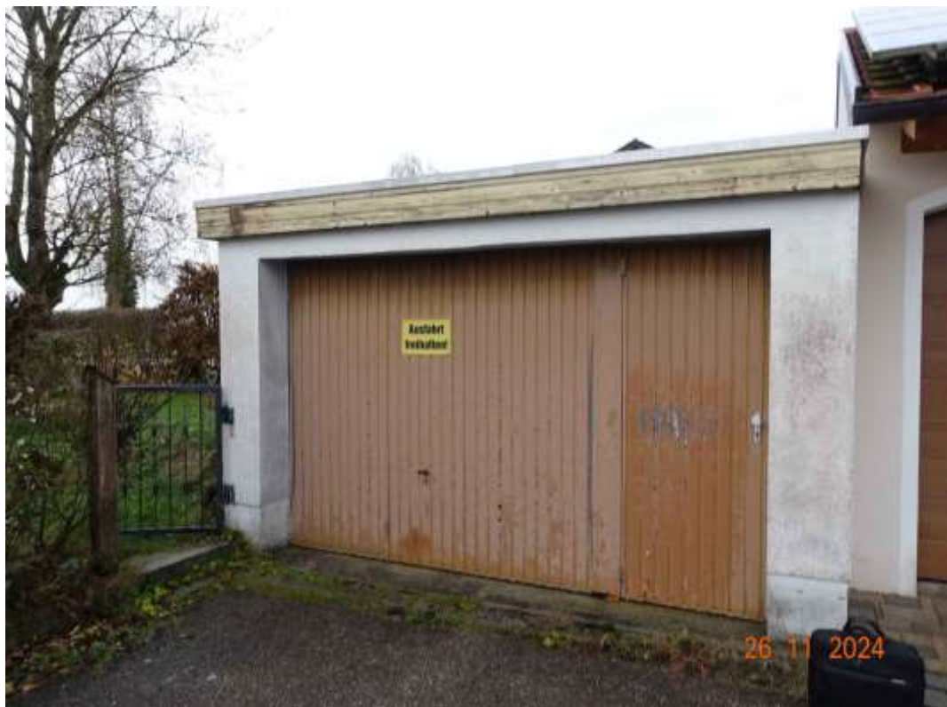
Abbildung 34: Einseitig angebaute Garage
