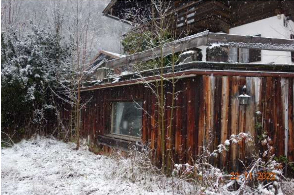
Abbildung 5: Unterkellerte Terrasse des Wohnhauses
