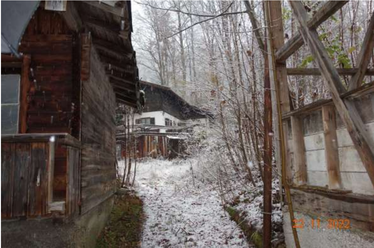
Abbildung 7: Linker Holzschuppen auf der Grundstücksgrenze von Flnr. 9/16 und 9/17
