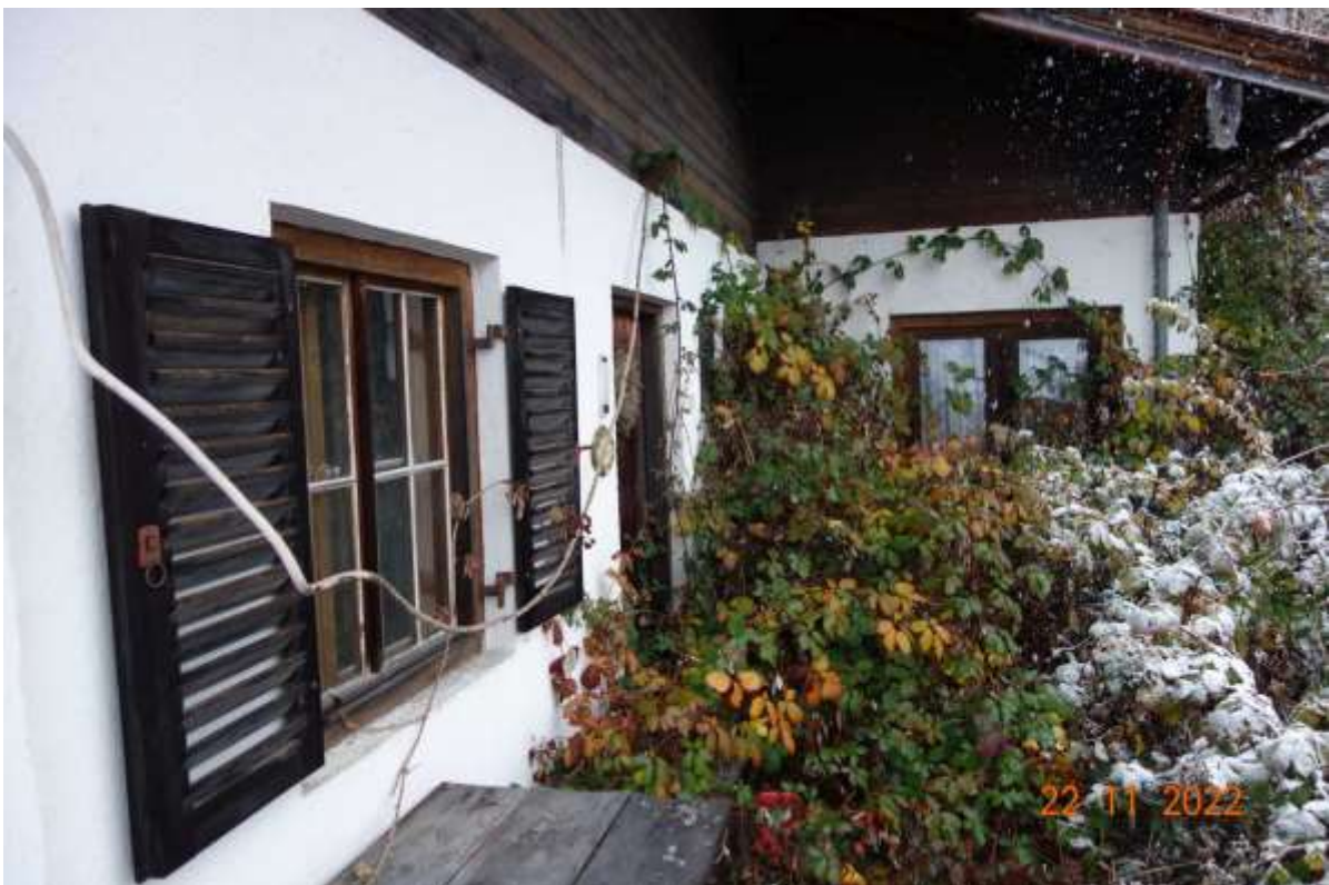
Abbildung 6: Wohnhaus mit überwucherter Hausabschlusstür
