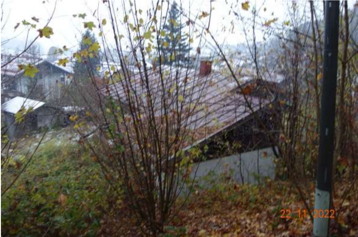
Abbildung 11: Ansicht des Wohnhauses auf Flnr. 9/3 vom nördlichen Fuß- oder Wanderweg
