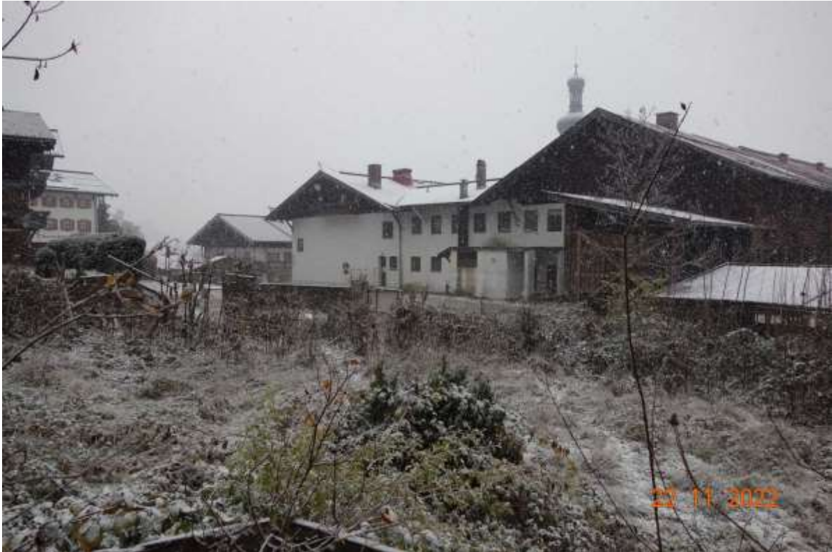
Abbildung 13: Blick auf das Grundstück mit Flnr. 9/17 mit umliegender Bebauung
