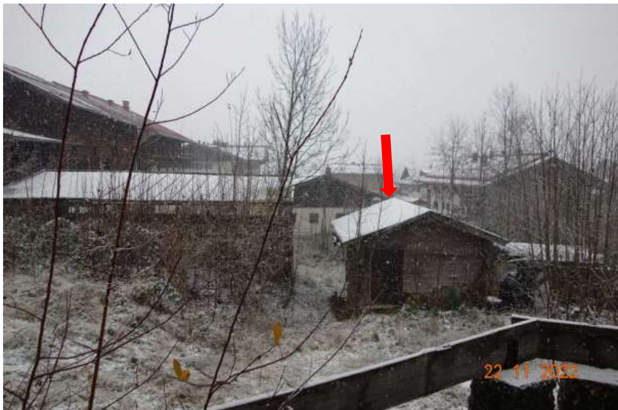
Abbildung 8: Holzschuppen auf der Grundstücksgrenze von Flnr. 9/16 und 9/17
