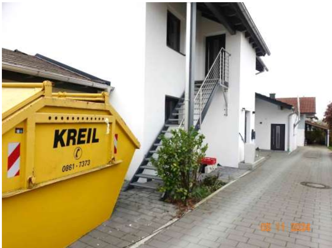
Abbildung 6: Außentreppe zu den Räumen im OG und DG
