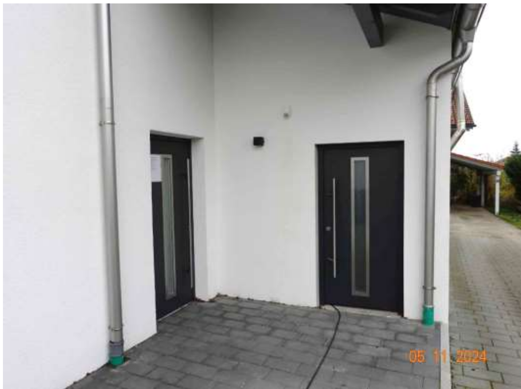
Abbildung 8: Weiterer Hauszugang und Zugang zum Anbau
