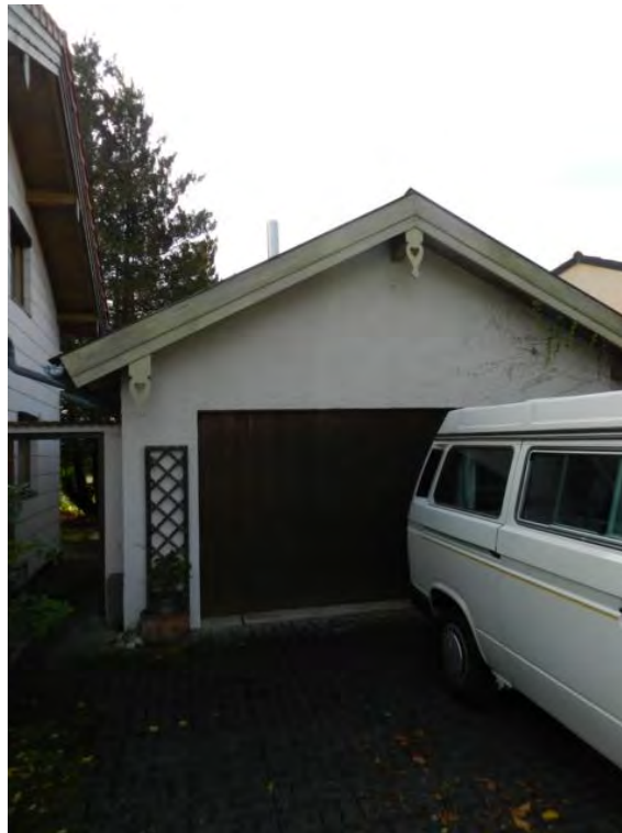
Garage, Ansicht von Nordost
