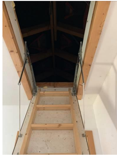
Blick in Dachboden
