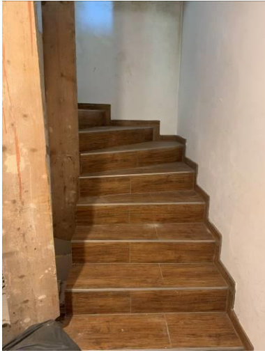
Treppe zum Erdgeschoss
