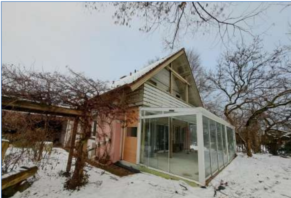
Ansicht von Südwesten bei der Zufahrt zum Haus
