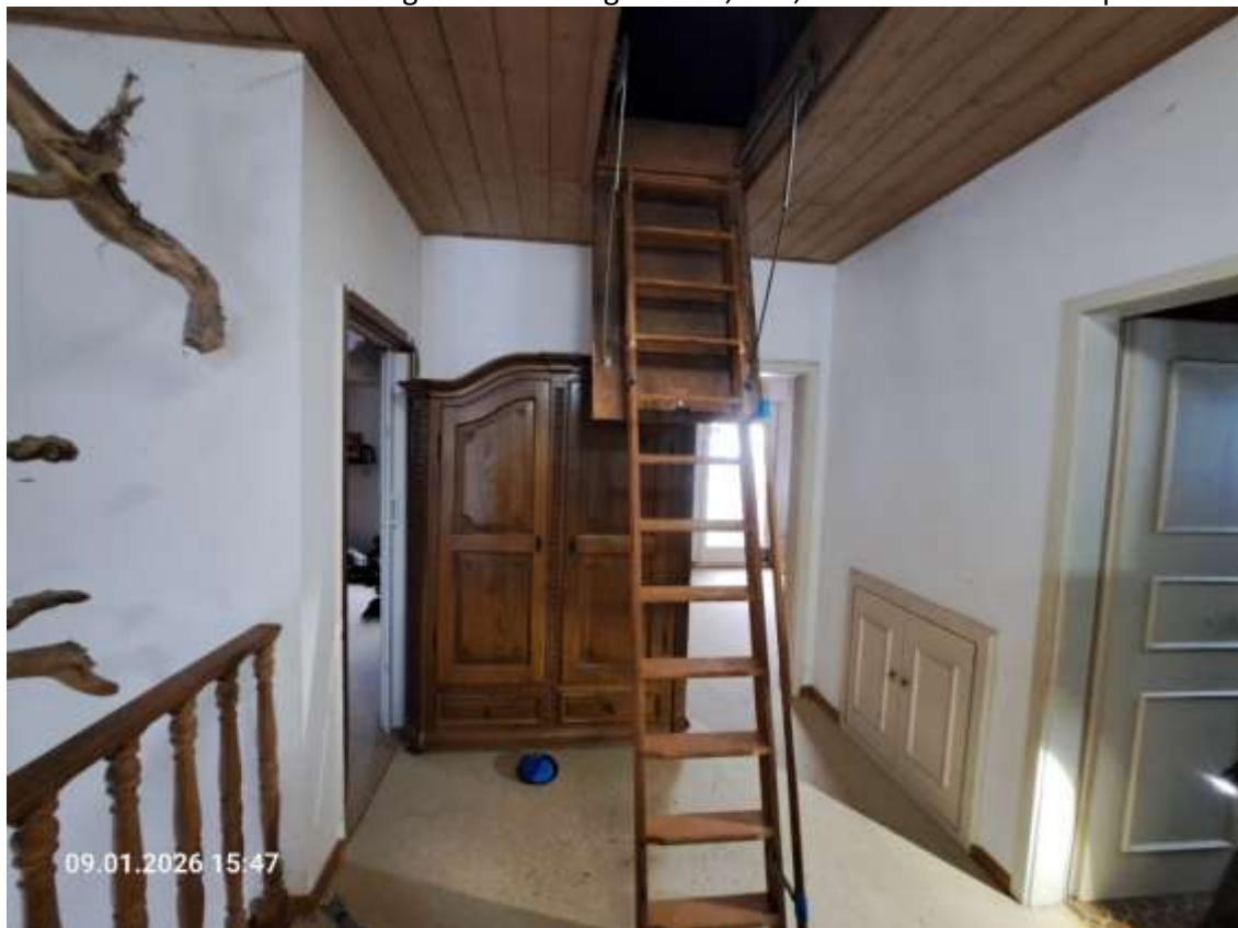
Ausgebautes Dachgeschoss, Flur, Ausziehleiter in den Spitzboden
