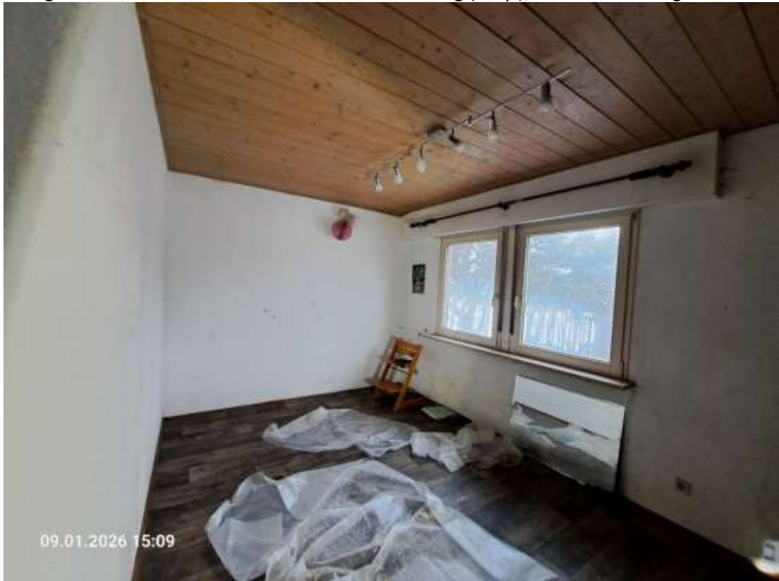
Erdgeschoss, ein Raum mit erneuertem Bodenbelag (Vinyl), Planbezeichnung: Schreiben
