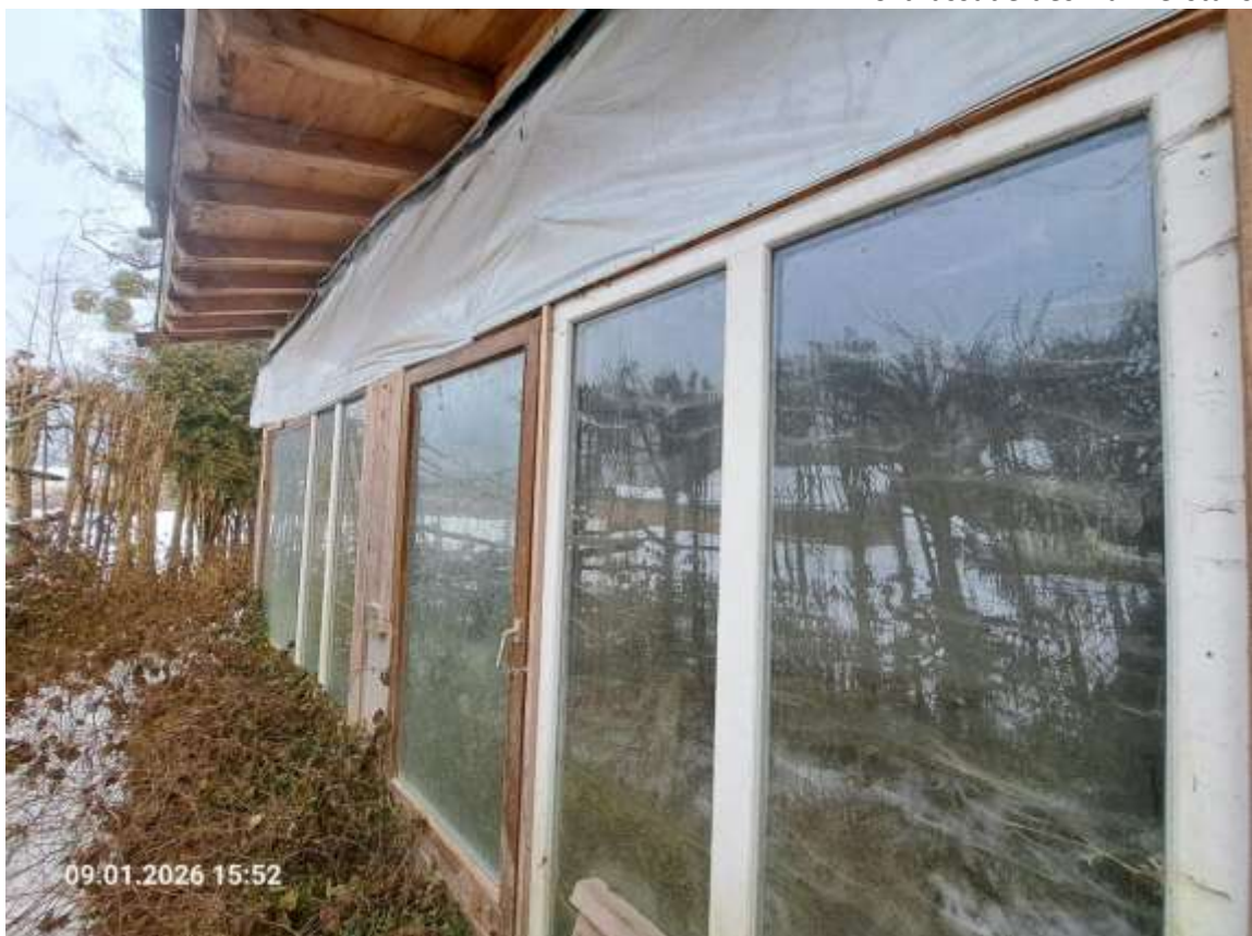
Nordfassade des Hühnerstalls
