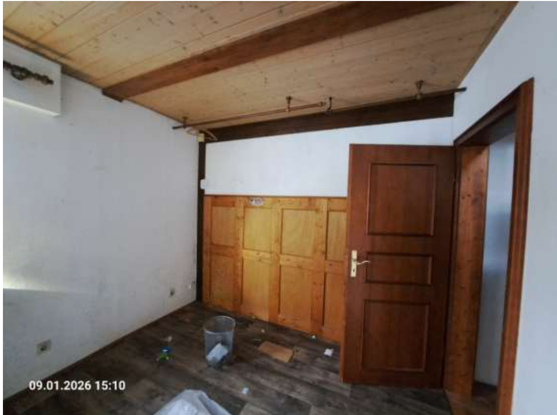
Erdgeschoss, Raum „Schreiben“ m. erneuertem Bodenbelag, Beispiel f. Innentüren aus d. Bauzeit
