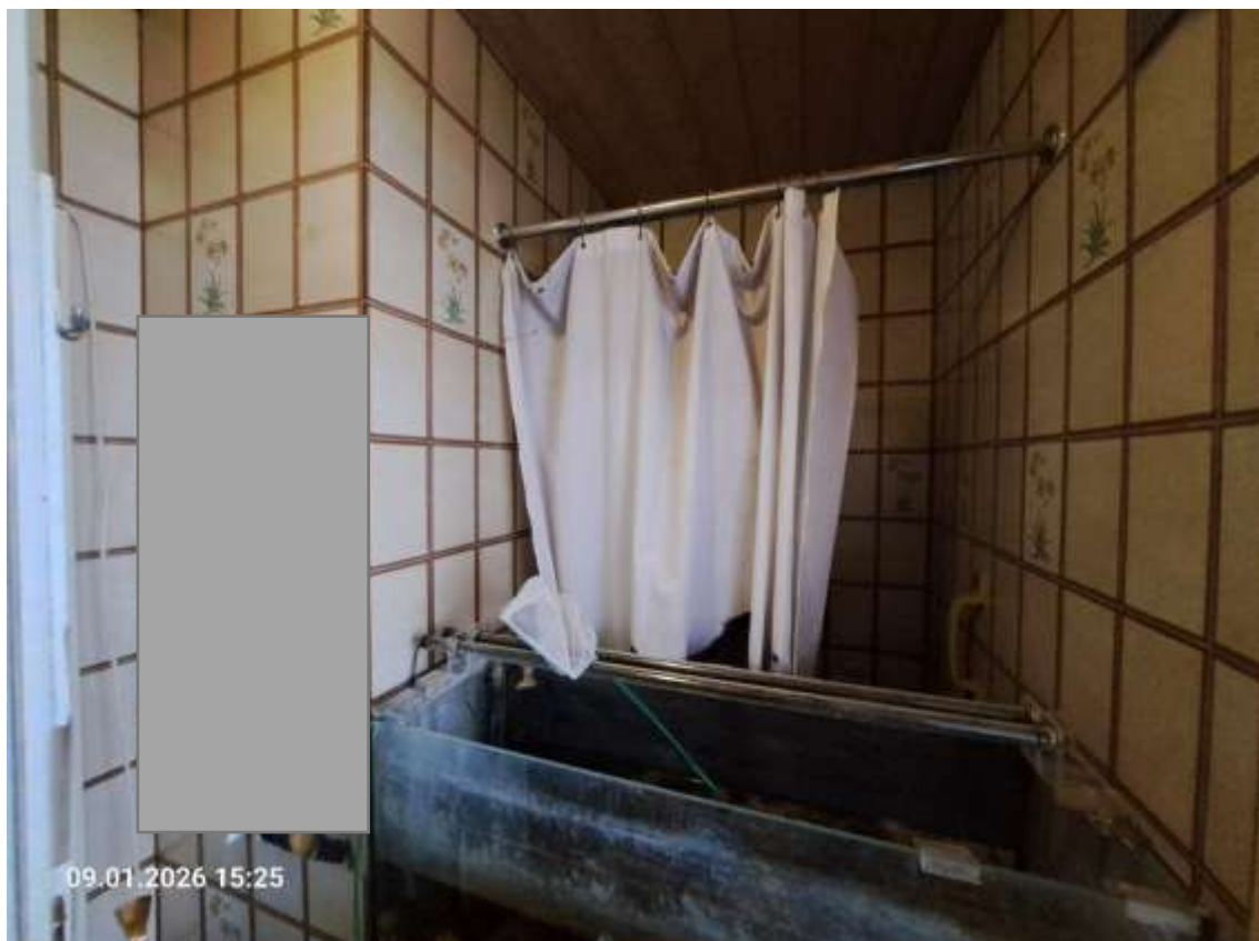
EG, Gäste-WC m. Waschbecken u. Dusche (hinter einem Aquarium, wurde offenbar n. genutzt)
