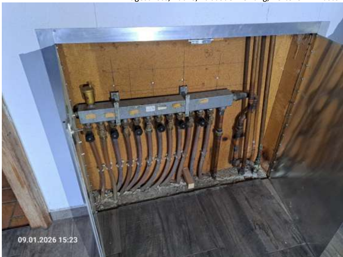
Erdgeschoss, Küche, Fußbodenheizung, Verteiler im Kasten
