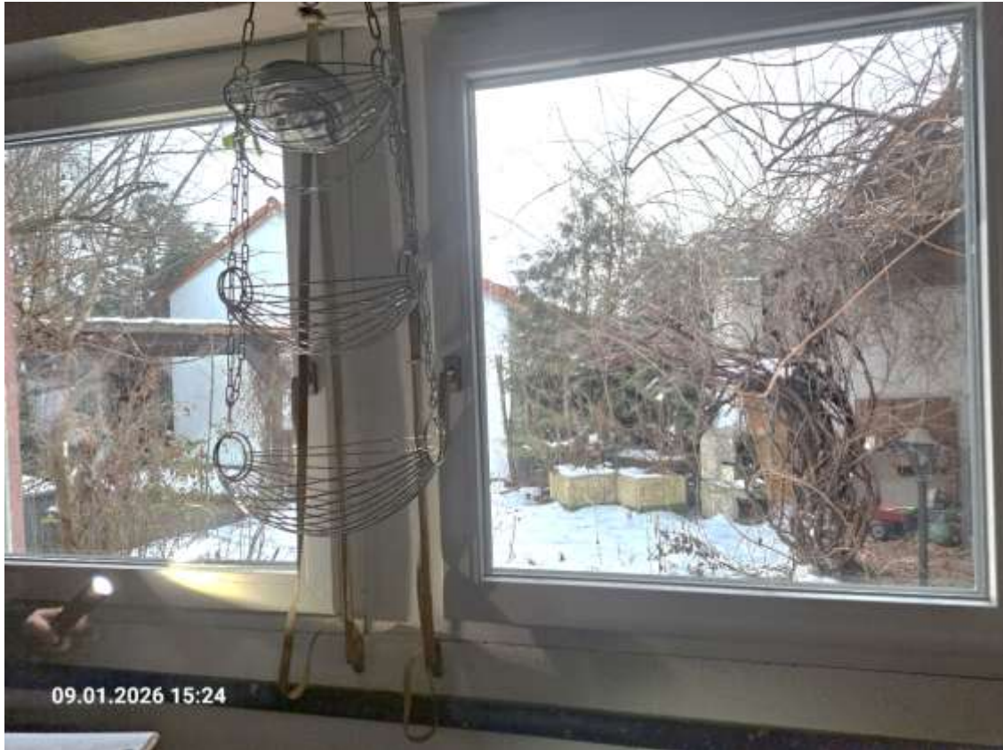
Erdgeschoss, Küche, zwei erneuerte Fenster, Blick Richtung Westen, Foto ist aufgehellt
