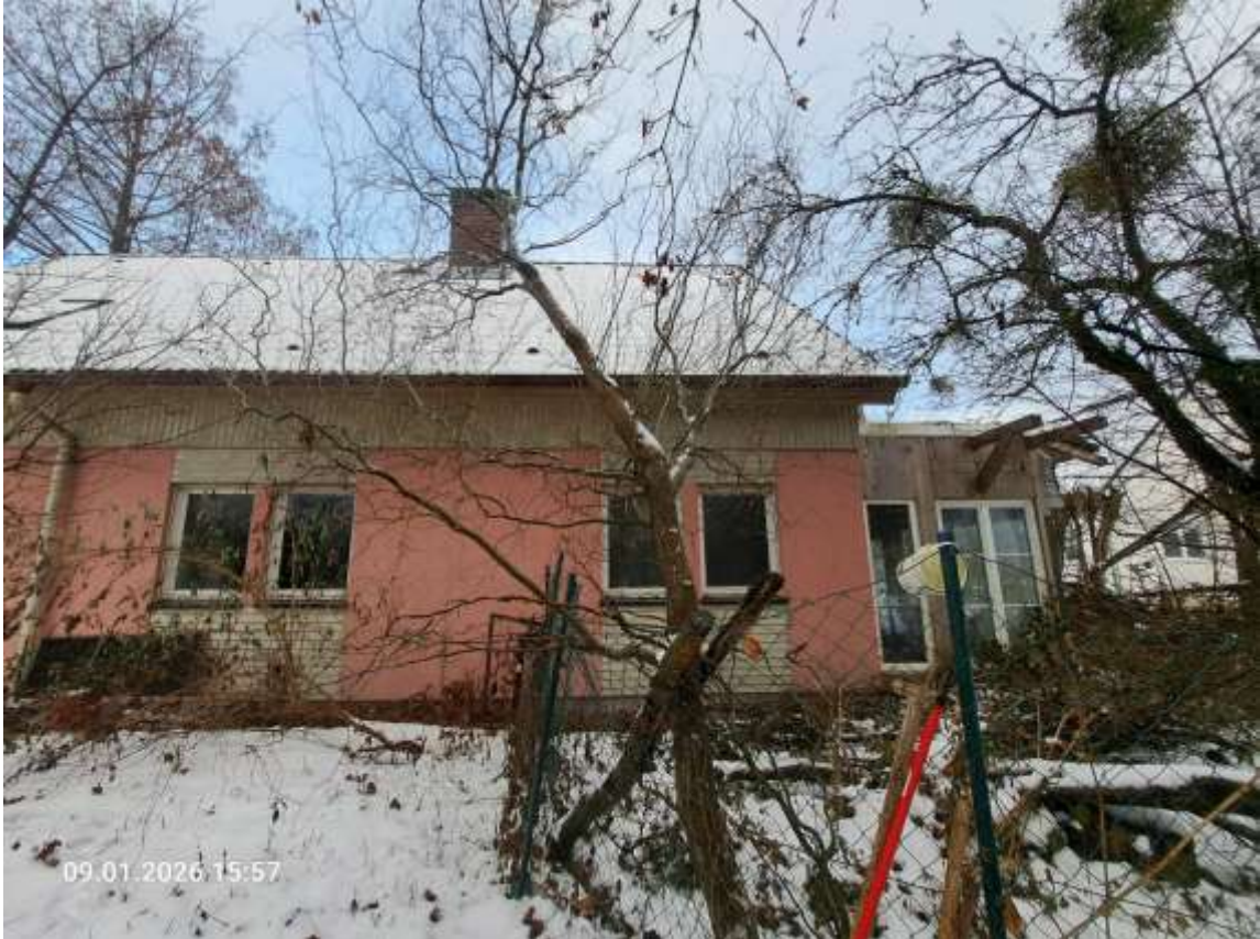
Ostfassade mit Hühnerstallanbau auf der Nordseite vom Haus
