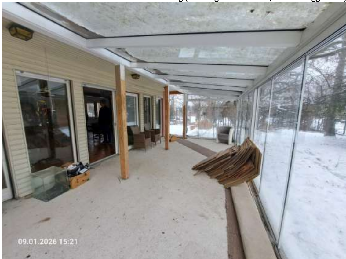
Erdgeschoss, Terrassenanbau beim Wohnzimmer, südseitig (Wintergarten-ähnlich, nicht fertiggestellt)
