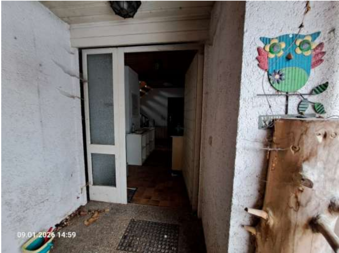
Eingang zum Haus auf der Westseite
