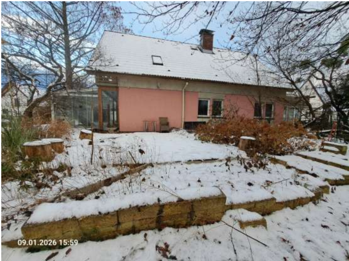
Gartenbereich auf der Ostseite mit Holzplattform als Freisitz (unter dem Schnee) und nicht verbautes Baumaterial
