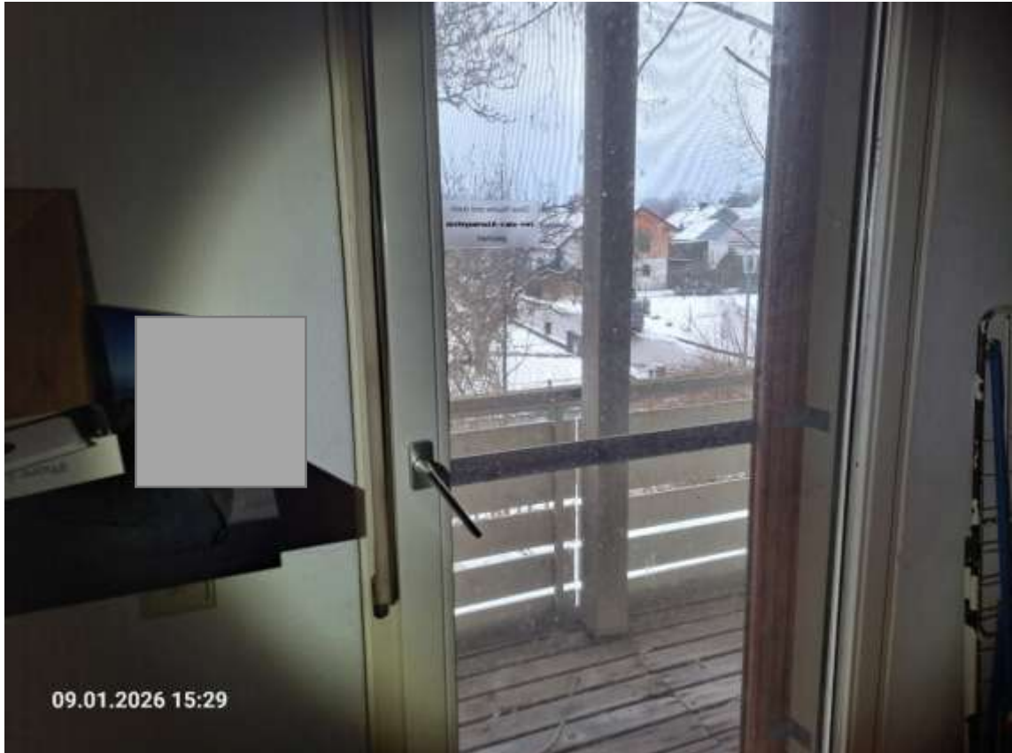
ausgebauten DG, Tür zum Balkon auf der Südseite
