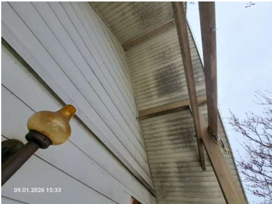
Blick zum Vordach über dem Balkon
