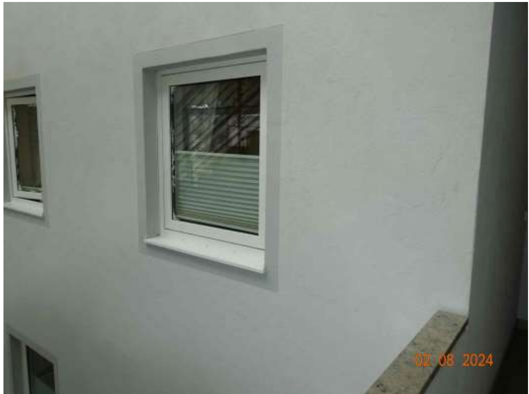
Abbildung 9: Küchenfenster der Wohnung Nr. 11 zum offenen Treppenraum
