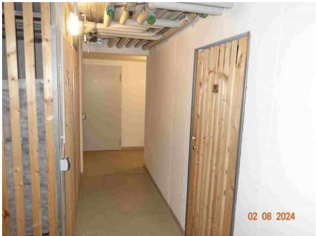
Abbildung 20: Keller mit Holzlaten zu den Kellerabteilen
