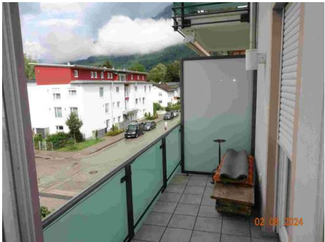
Abbildung 16: Balkon der Wohnung mit Zugang vom Wohnraum und Schlafraum
