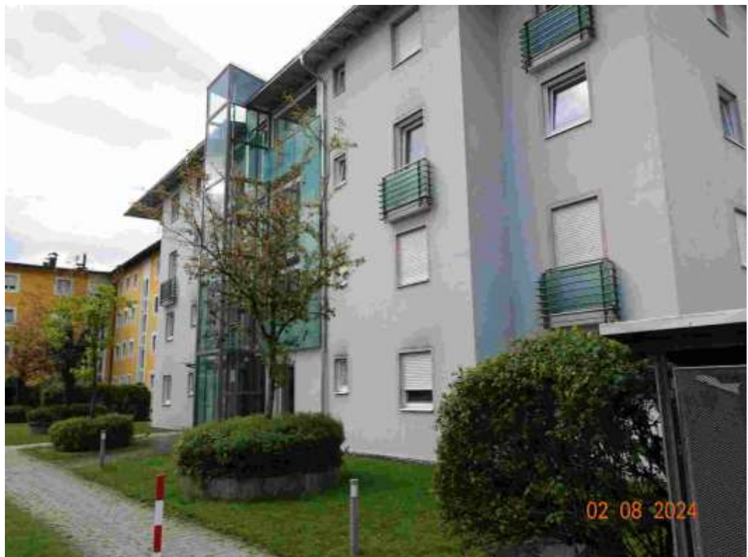
Abbildung 4: Fassade auf der Hauszugangsseite
