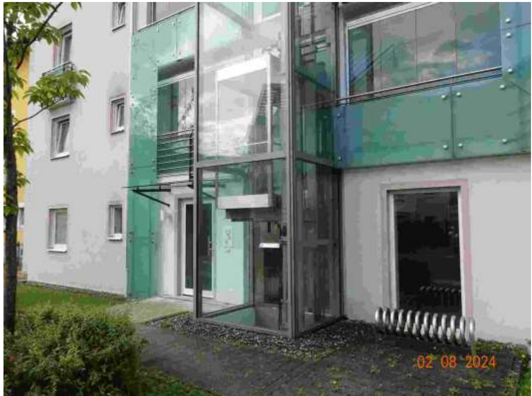
Abbildung 5: Hauszugang mit verglastem Personenaufzug
