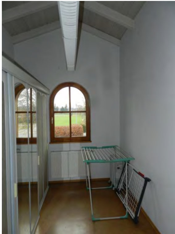
Küche (Anschlüsse nicht hergestellt), OG (DG), WE 2
