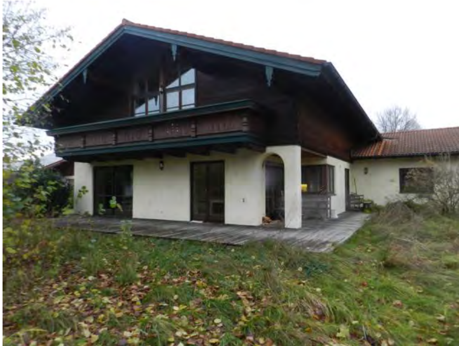
Südostfassade und Südwestgiebel
