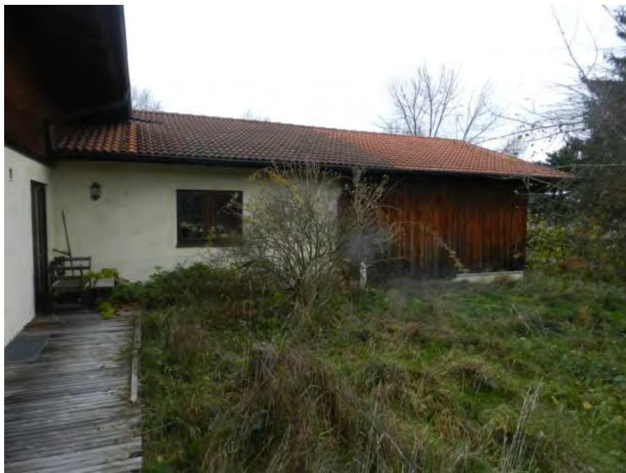
Blick auf Garage von Südwest
