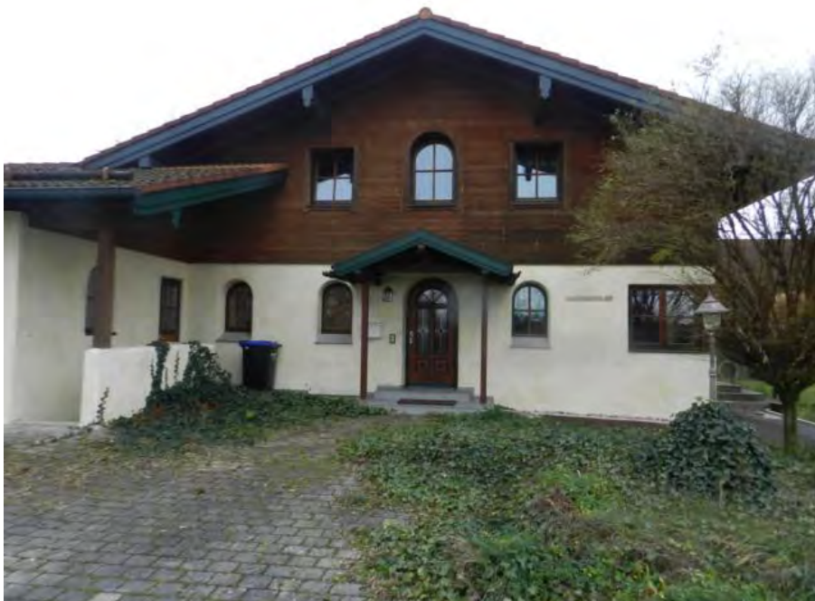
Nordostfassade; Hauszugang zur Wohnung WE 1
