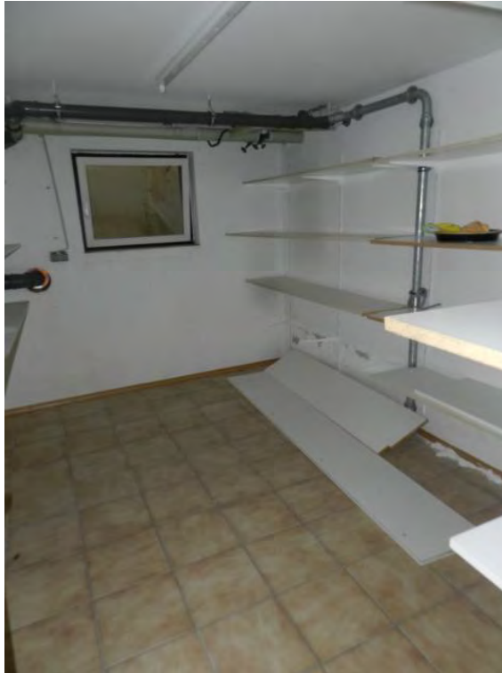
Kellerraum 1, KG, WE 1
