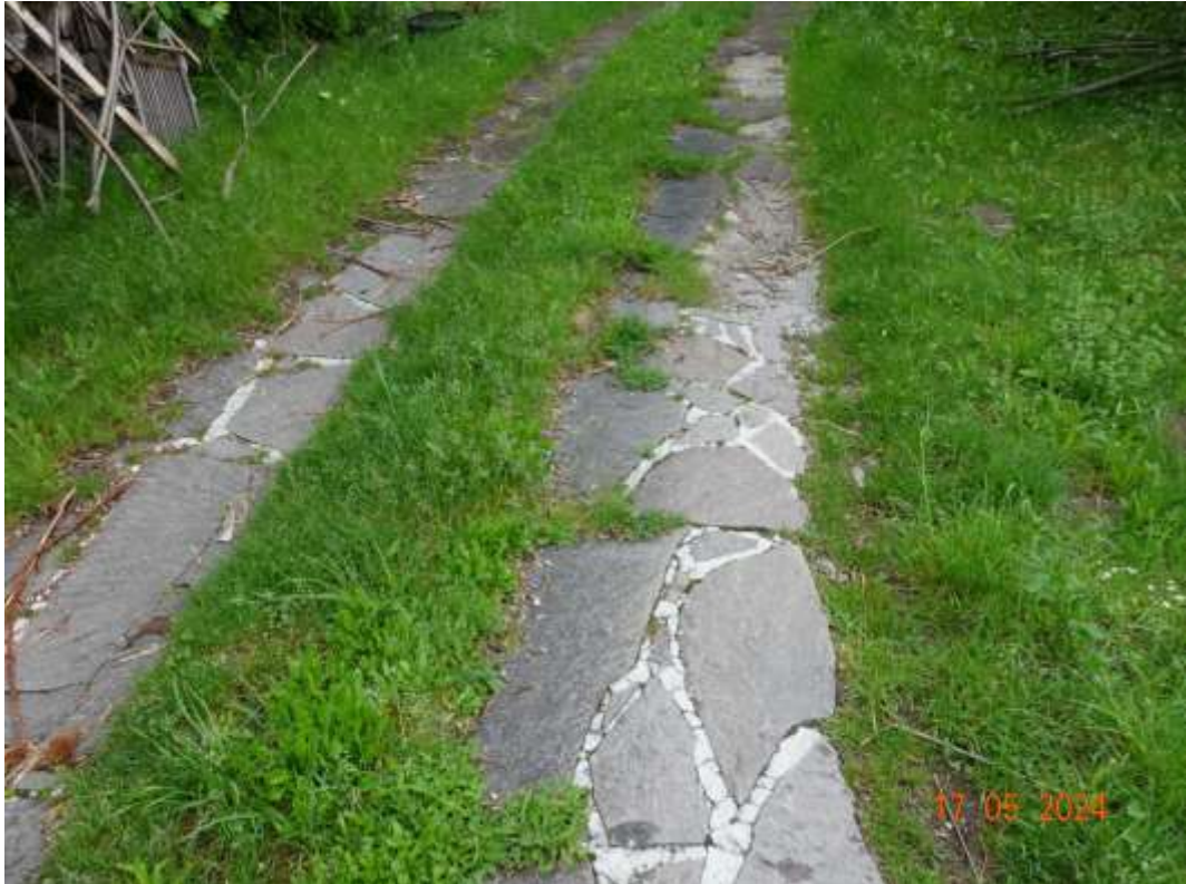
Abbildung 5: Zufahrt über Porphybruch, teilweise aufgeworfen
