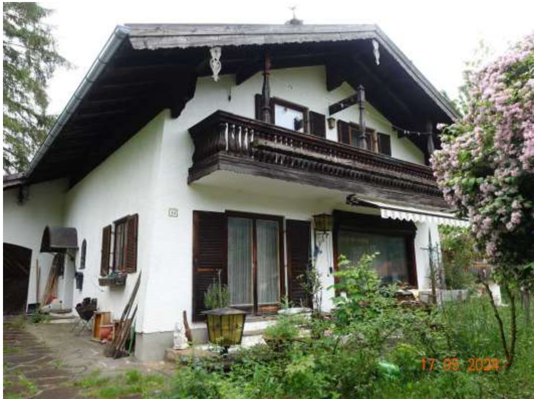
Abbildung 7: Ansicht des Wohnhauses von Nordwesten
