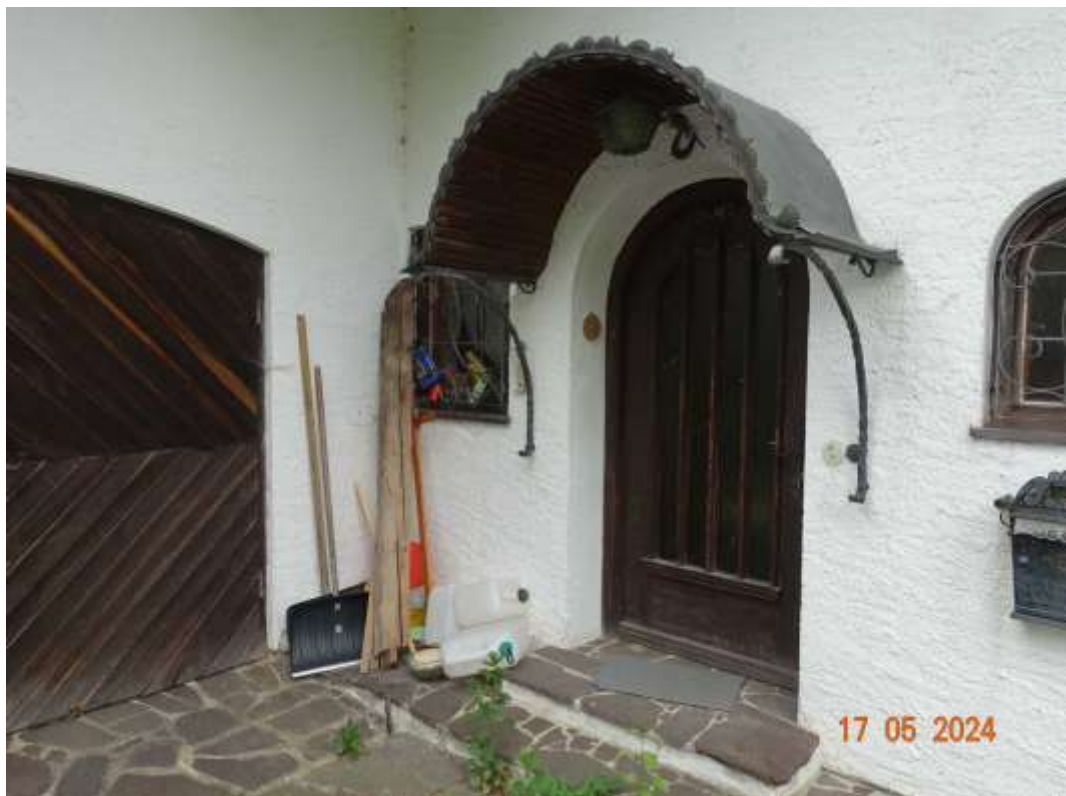
Abbildung 8: Hauszugang, teilweise überdeckt
