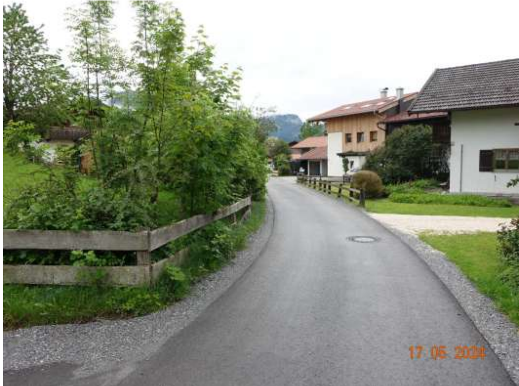
Abbildung 1: Ansicht der (erneuerten) Zufahrt über die Weitwiesstraße
