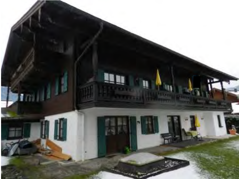
Gartenstr. 3, Ansicht Südwestfassade
