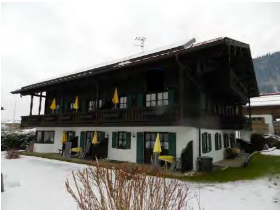
Gartenstr. 3, Ansicht Südwestfassade und Südostgiebel
