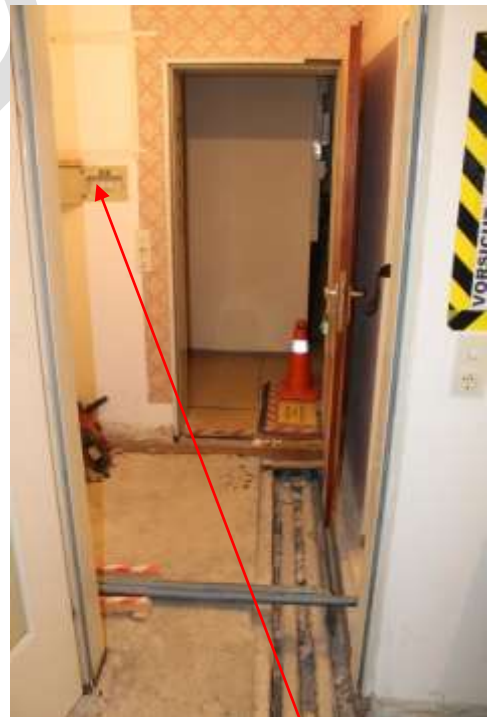
Abb. 11a: Blick vom Wohnungsflur ins Treppenhaus, Sicherungskasten
