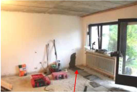
Abb. 14b: Wohnzimmer – Blick Südosten
