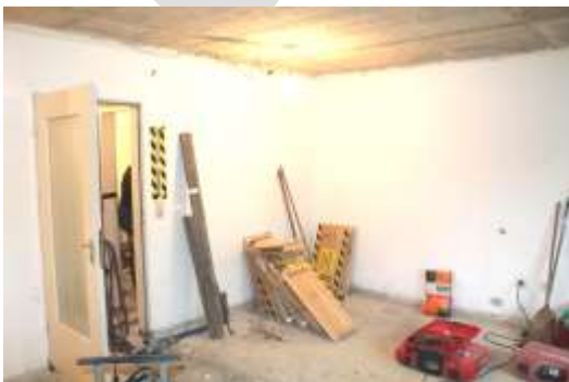
Abb. 14 d: Wohnzimmer Blick zum Flur
