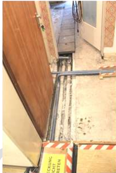
Abb. 11: Wohnungseingang Nr. 2, Leitungserneuerung, Revisionschacht
