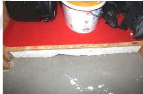
Abb. 23a: Bodendämmung von Speicherabteil Nr. 2
