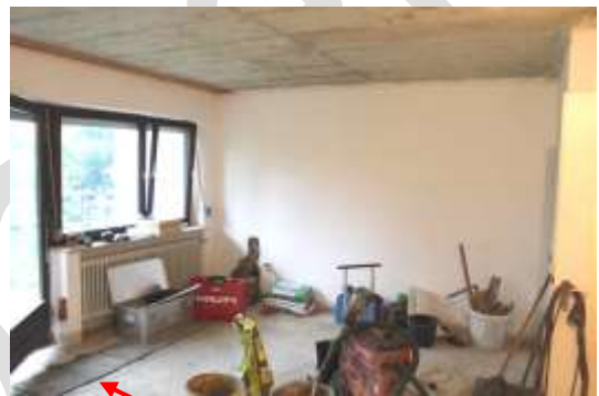
Abb. 14: Wohnzimmer Blick Südwesten, unverputzte Decke, Revisionschacht
