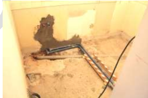
Abb. 15a: Küche Leitungssanierung
