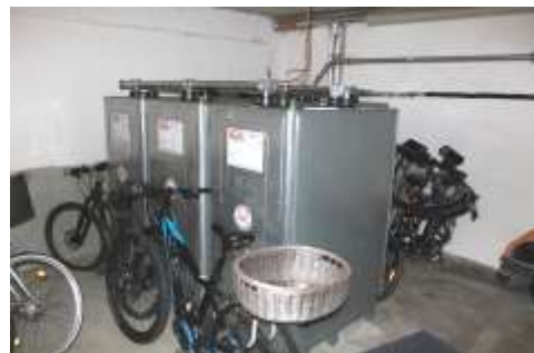
Abb. 20: Heizöltanks
