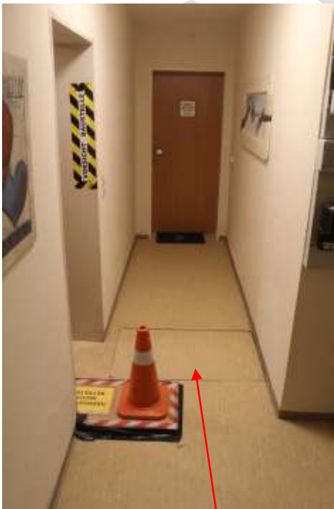
Abb. 10: Flur UG, Schachtöffnung
