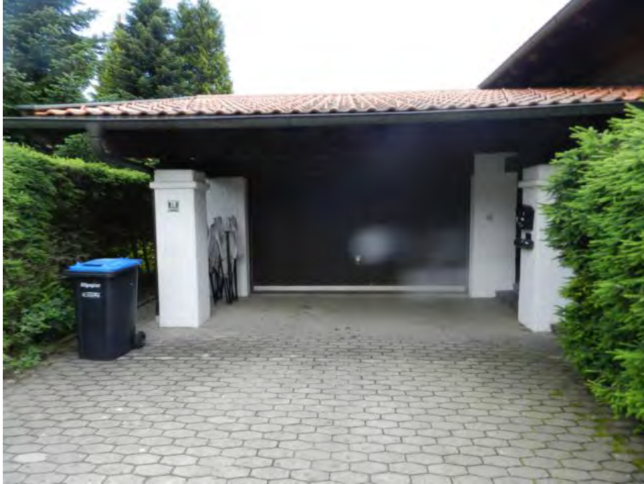
Garage, Ansicht von Westen
