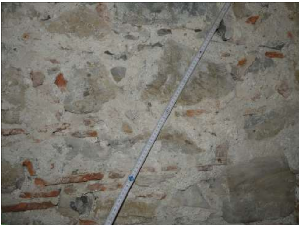
Bild 5 Diele EG, frühere Außenwand, Mischmauerwerk
