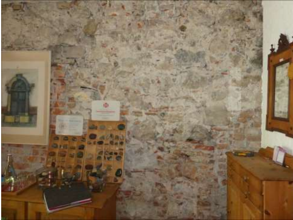
Bild 4: Diele EG, frühere Außenwand
