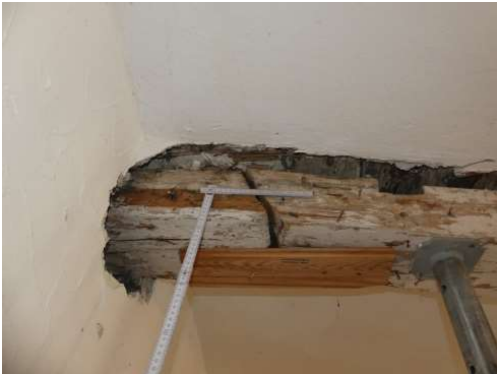
Bild 20: Deckenbalken Stoß
