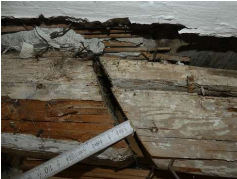
Bild 21: Deckenbalken Stoß
