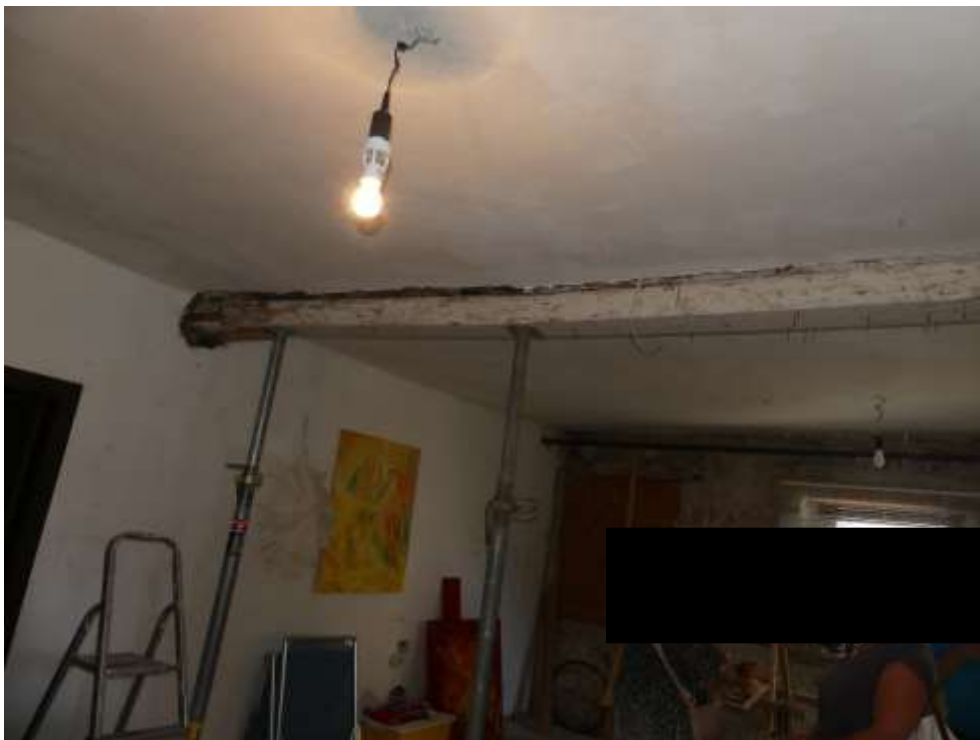
Bild 18: Holzbalken unter der Decke
