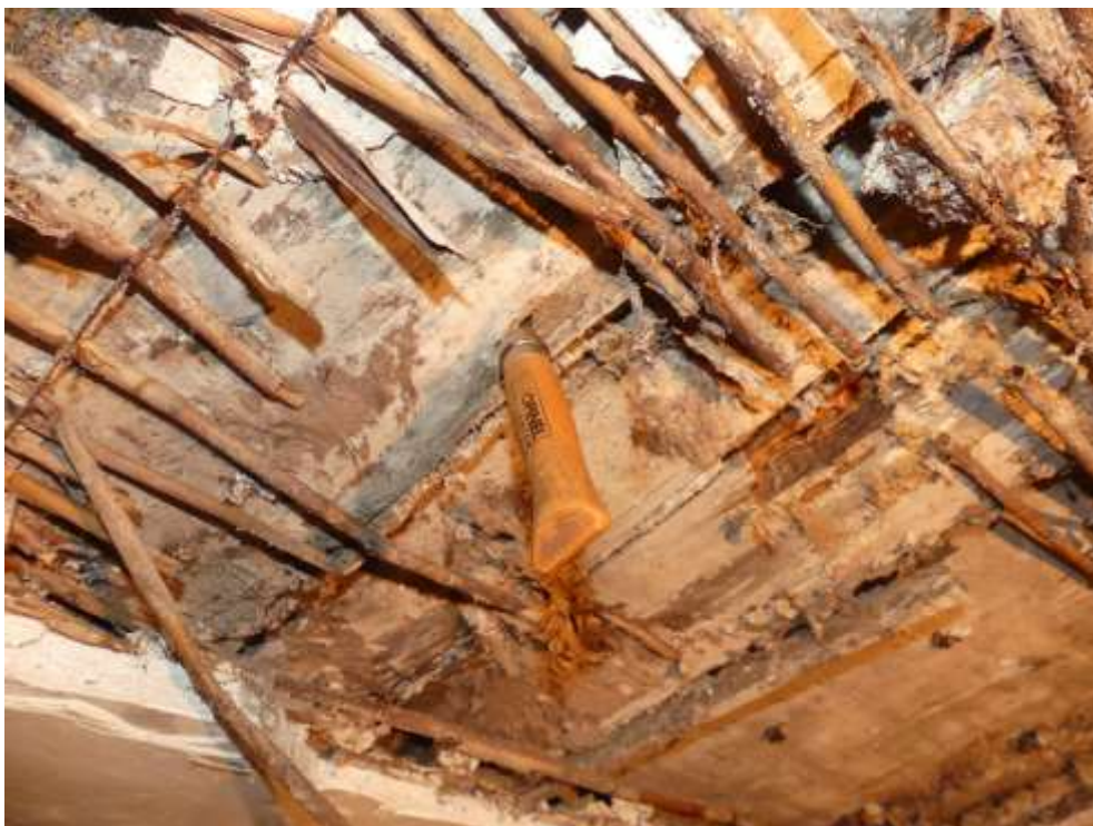
Bild 23: Deckenbalken geschädigt
