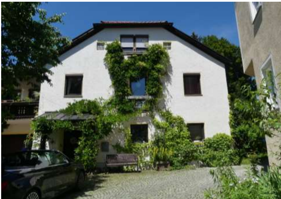
Bild 1: Südansicht des Gebäudes
