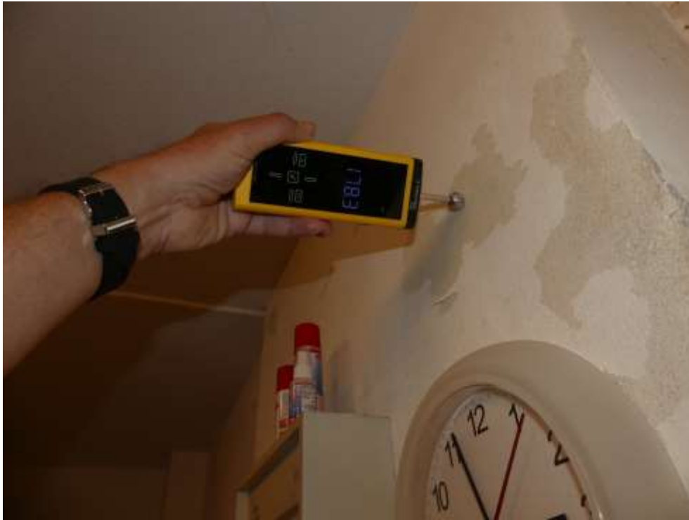
Bild 16: Raum unterhalb der Treppe
