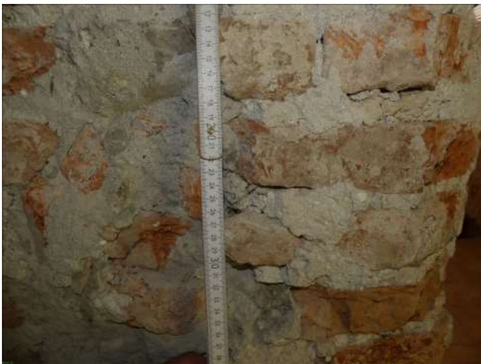
Bild 3 Diele EG, Mauerwerk Trennwand Ost
