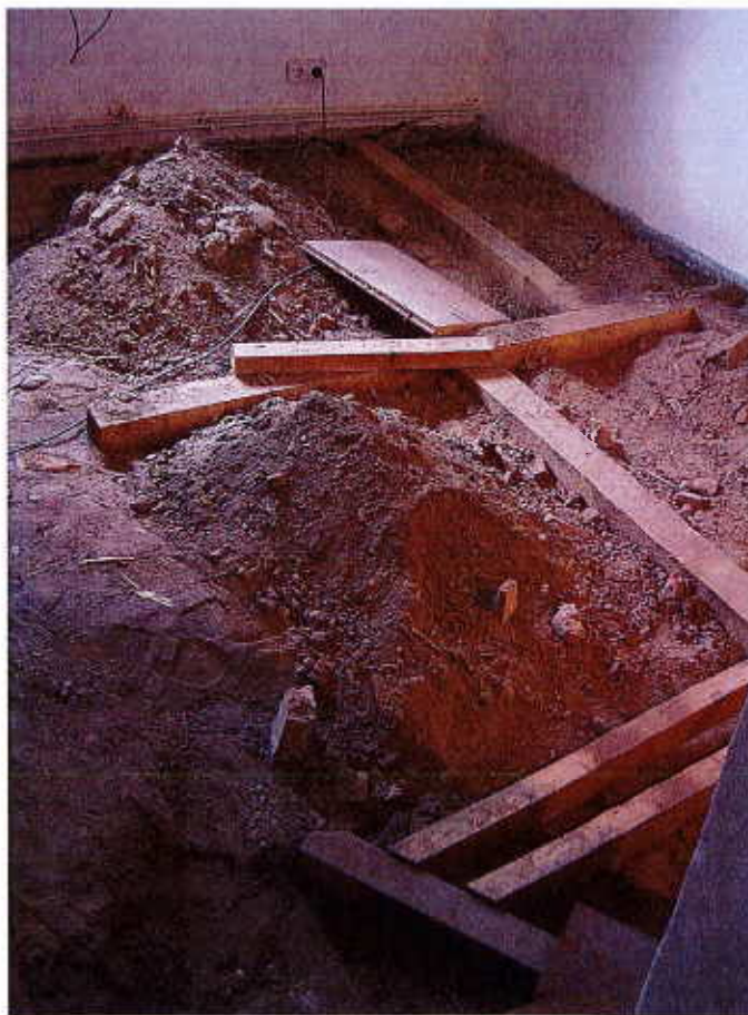
Ausschnitt aus geöffnetem Bodenbelag OG
