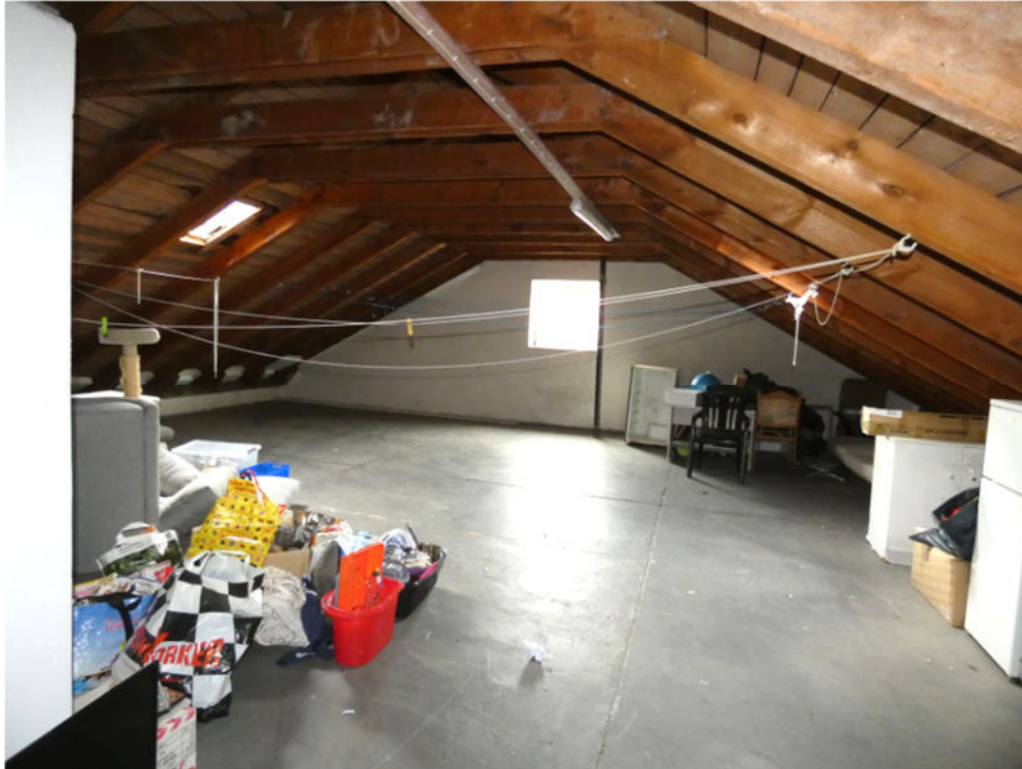
Bild 16: Blick in den Dachraum
