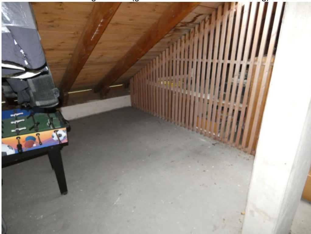
Bild 15: Abteil im Dachgeschoss (gehört nicht offiziell zur Wohnung)
