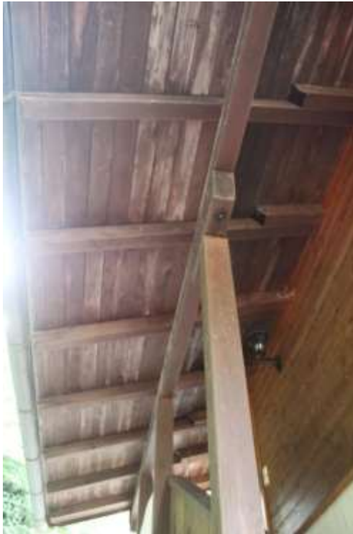
Abb.11: Zustand Dachuntersicht bei Außentreppe
