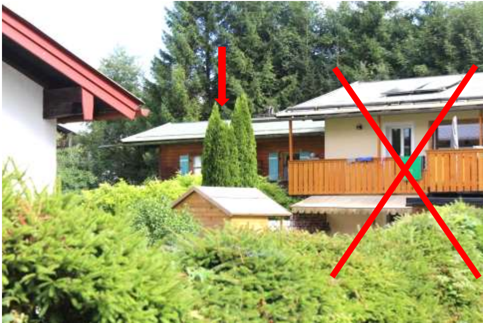
Abb. 13: Veranschaulichung der Anbausituation, Bewertungsobjekt mit Pfeil gekennzeichnet
