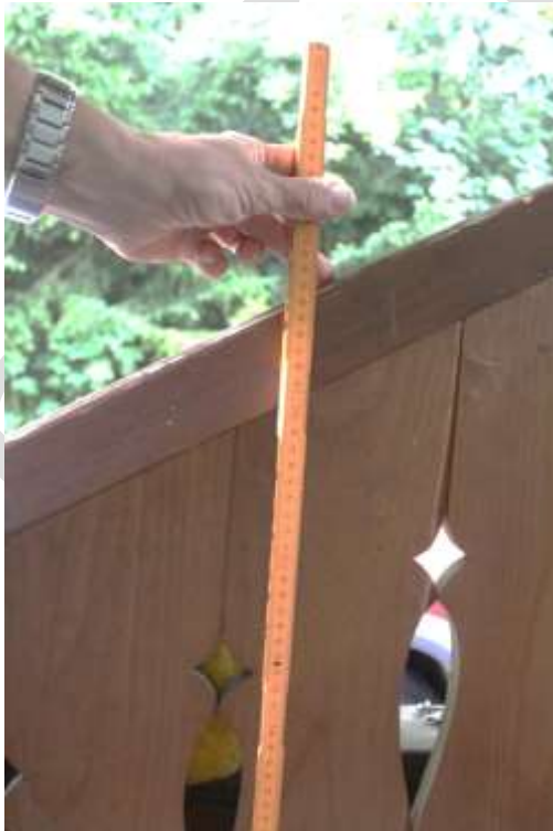
Abb. 10a: Geländerhöhe nur 87 cm
