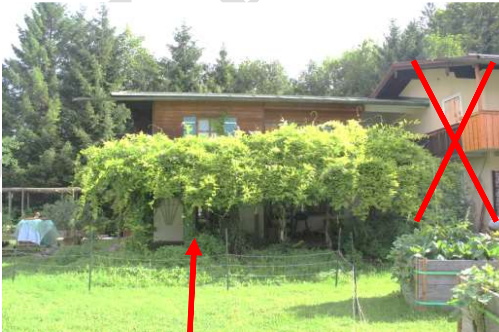
Abb. 4: FlNr. 660/18 – Gebäude-Südansicht, Terrassenbewuchs
