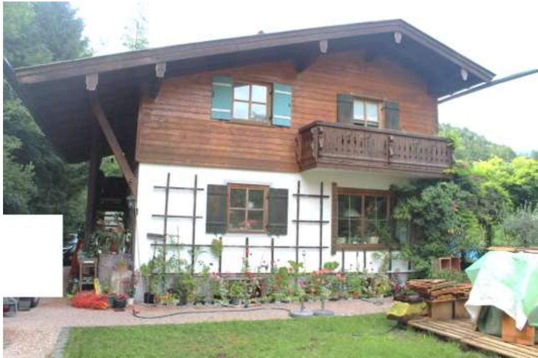
Abb. 1: FlNr. 660/18 Westansicht Wohnhaus
