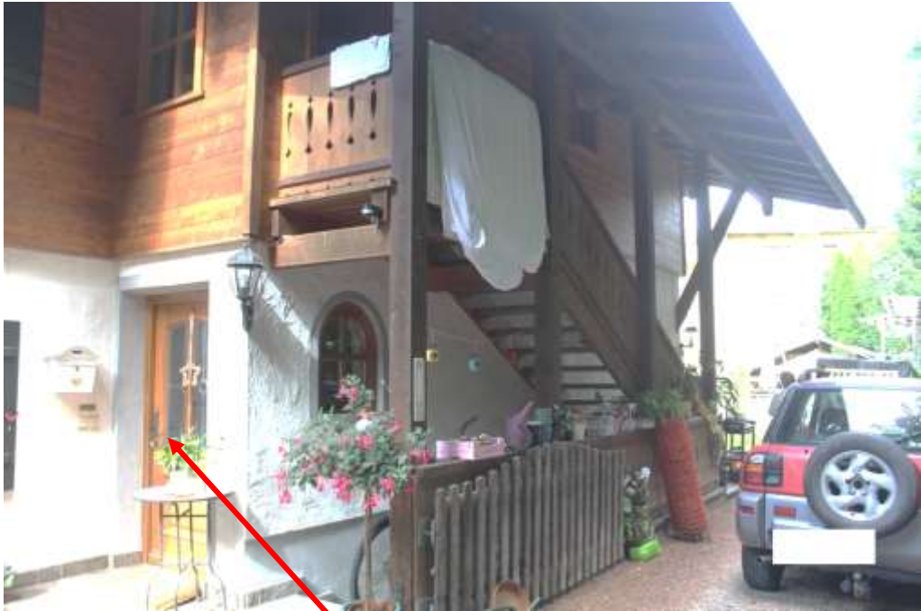
Abb. 5: Nordostansicht – Eingang EG-Wohnung, Außenaufgang zur OG-/DG-Wohnung
