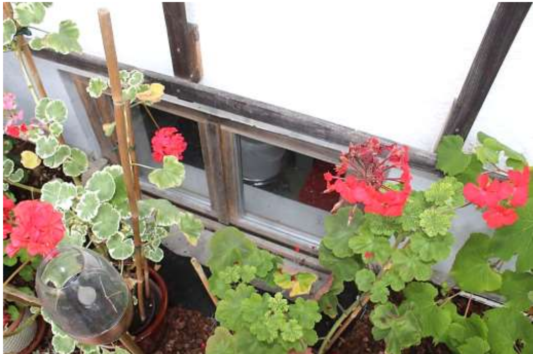
Abb. 12a: Zustand Holzteile – Kellerfenster
