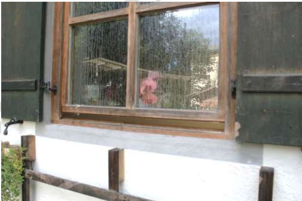
Abb. 12: Zustand Außenholzteile Fenster – beispielhaft
