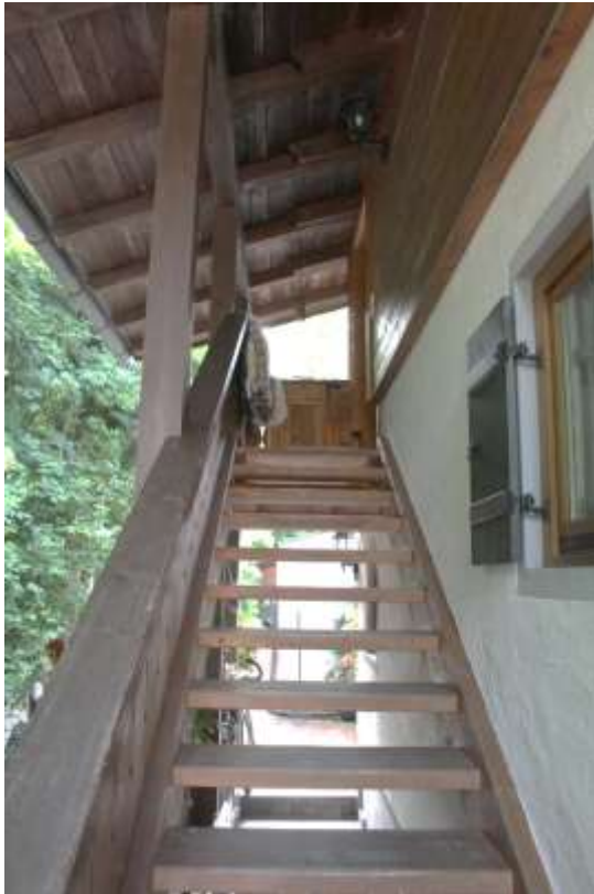
Abb. 10: Außentreppe ins OG/DG
