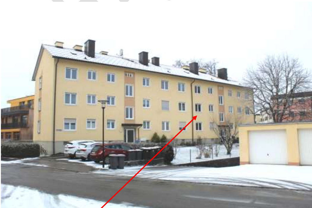
Abb. 2: Nordostansicht – Whg. Nr. 3
