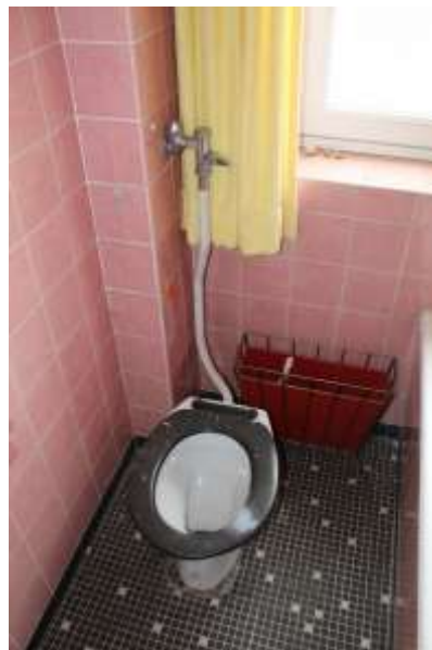
Abb. 8d: Bad, Toilette mit Druckspülung
