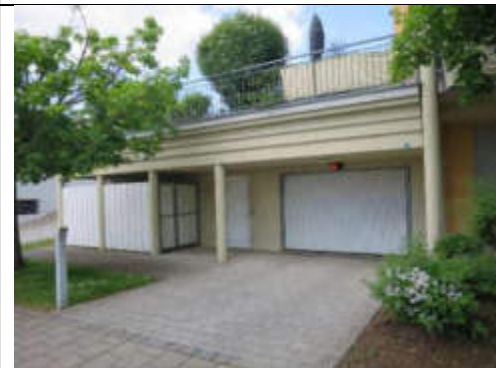
Zufahrt zur Tiefgarage und Zugang Müllhaus
