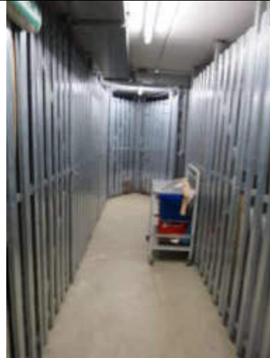
UG - Kellerabteile (Metalllattenverschlag)
