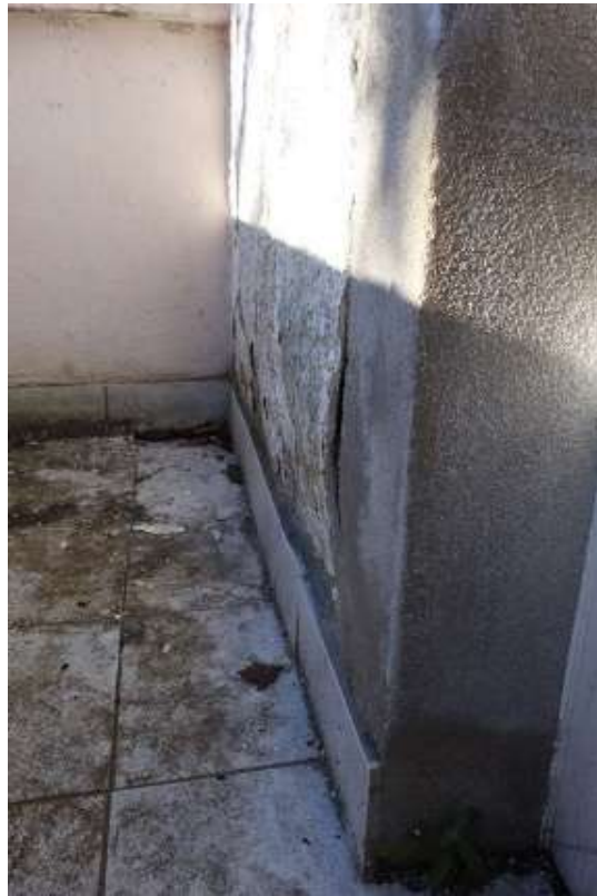
Außenwand beim Balkon, Putzschäden, Hohlraum unter dem Putz
