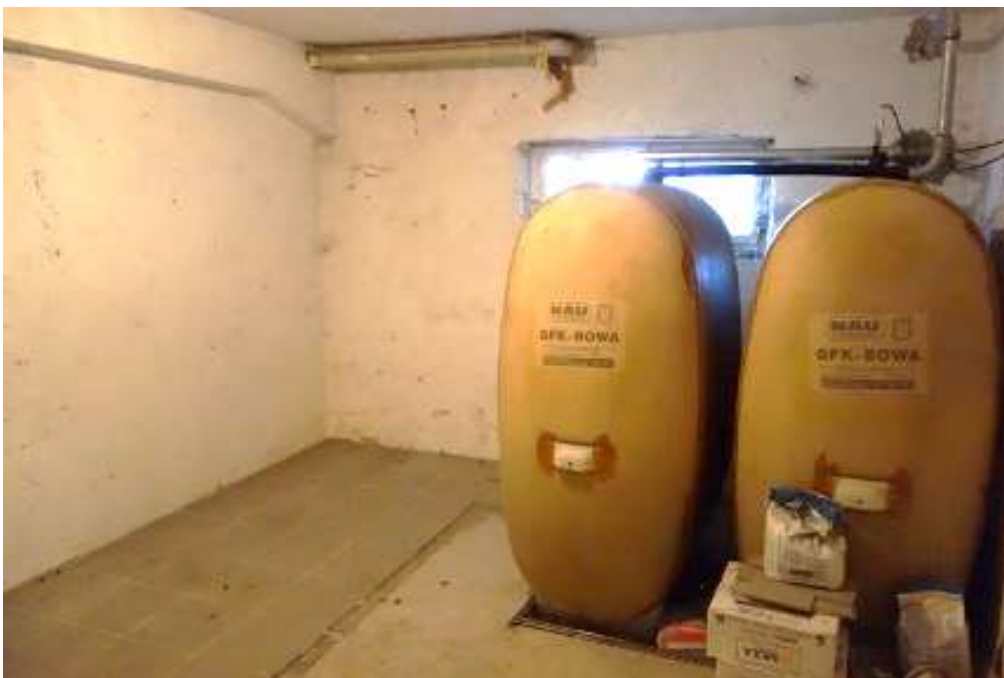
Kellerraum, ältere Öltanks, partielle Erneuerung des Bodenbelags (Foto aufgehellt)
