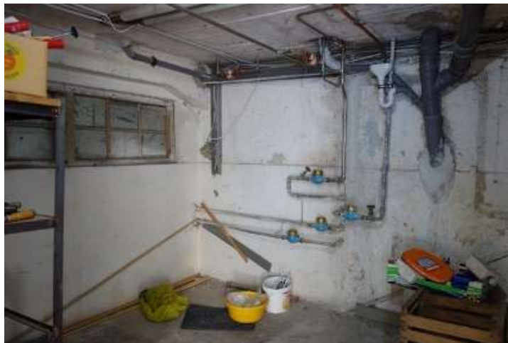
Weiterer Kellerraum mit erneuerten Wasseruhren, Leitungen teils erneuert
