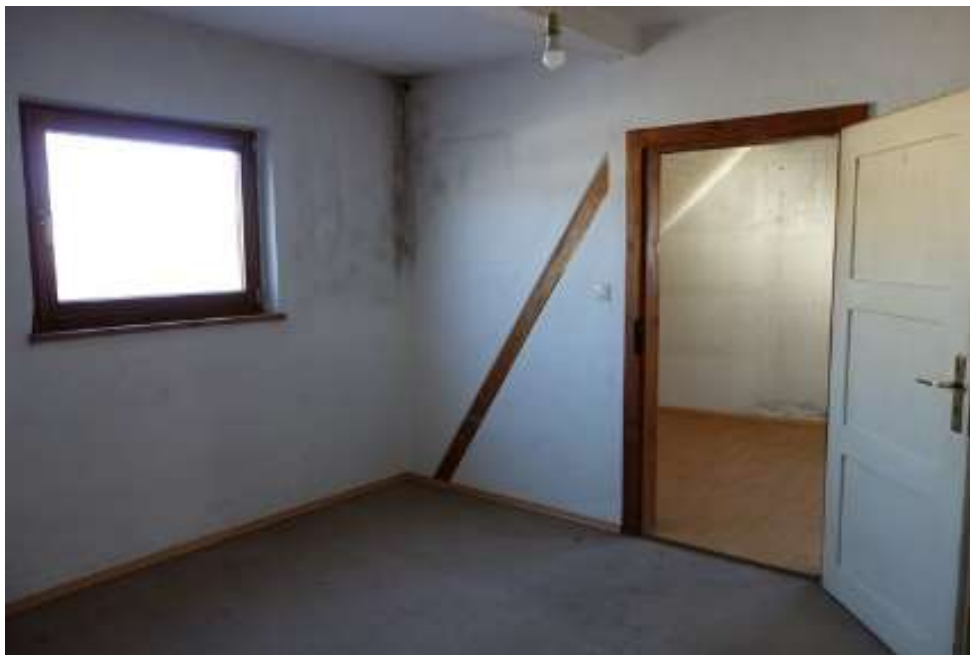
Obergeschoss Wohnraum Schleppgaube nach Norden, Schimmel in den Ecken
