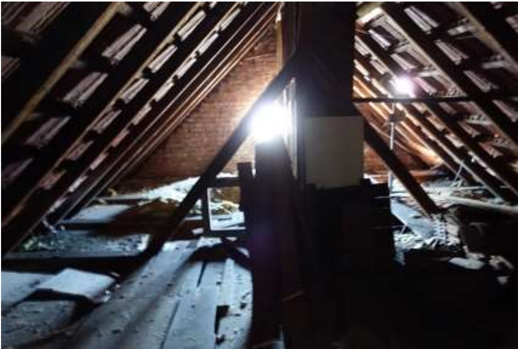
Dachboden mit losen Brettern, Dach ohne Schalung
