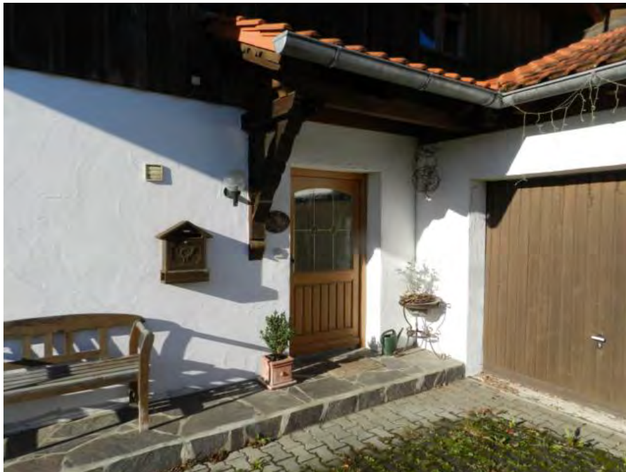
Hauseingang in Nordostfassade
