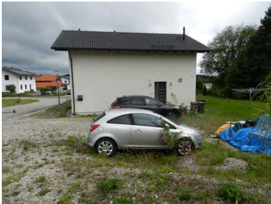
Ansicht auf Nordfassade, Hauseingang
