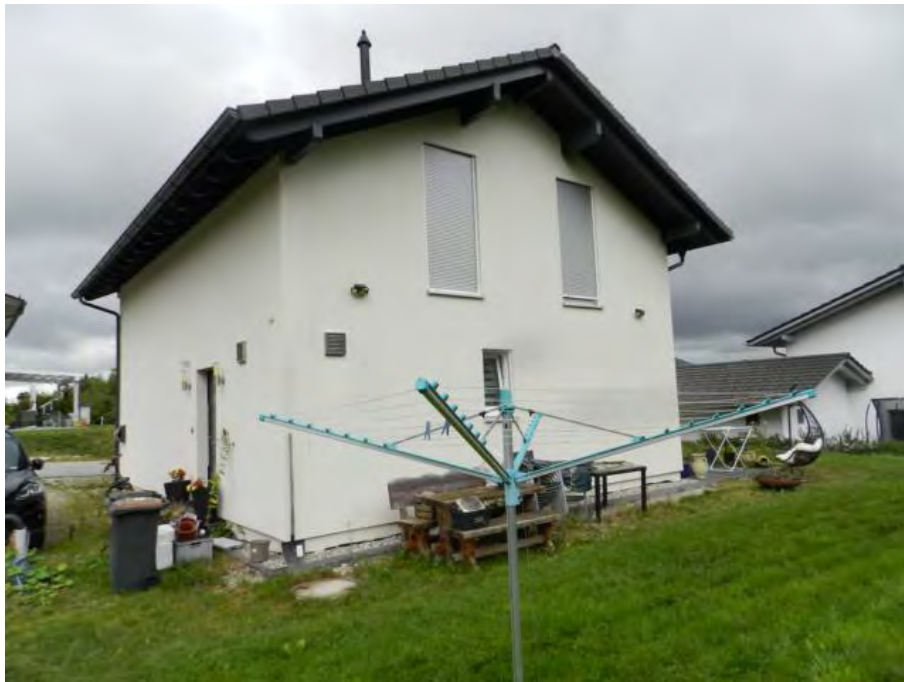
Ansicht auf Westgiebel und Nordfassade
