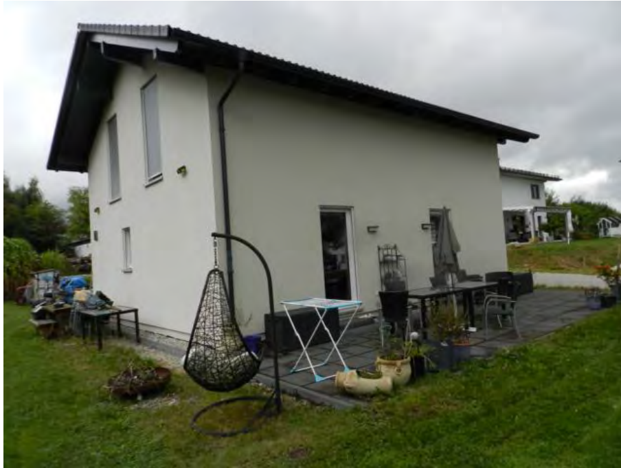
Ansicht auf Westgiebel und Südfassade
