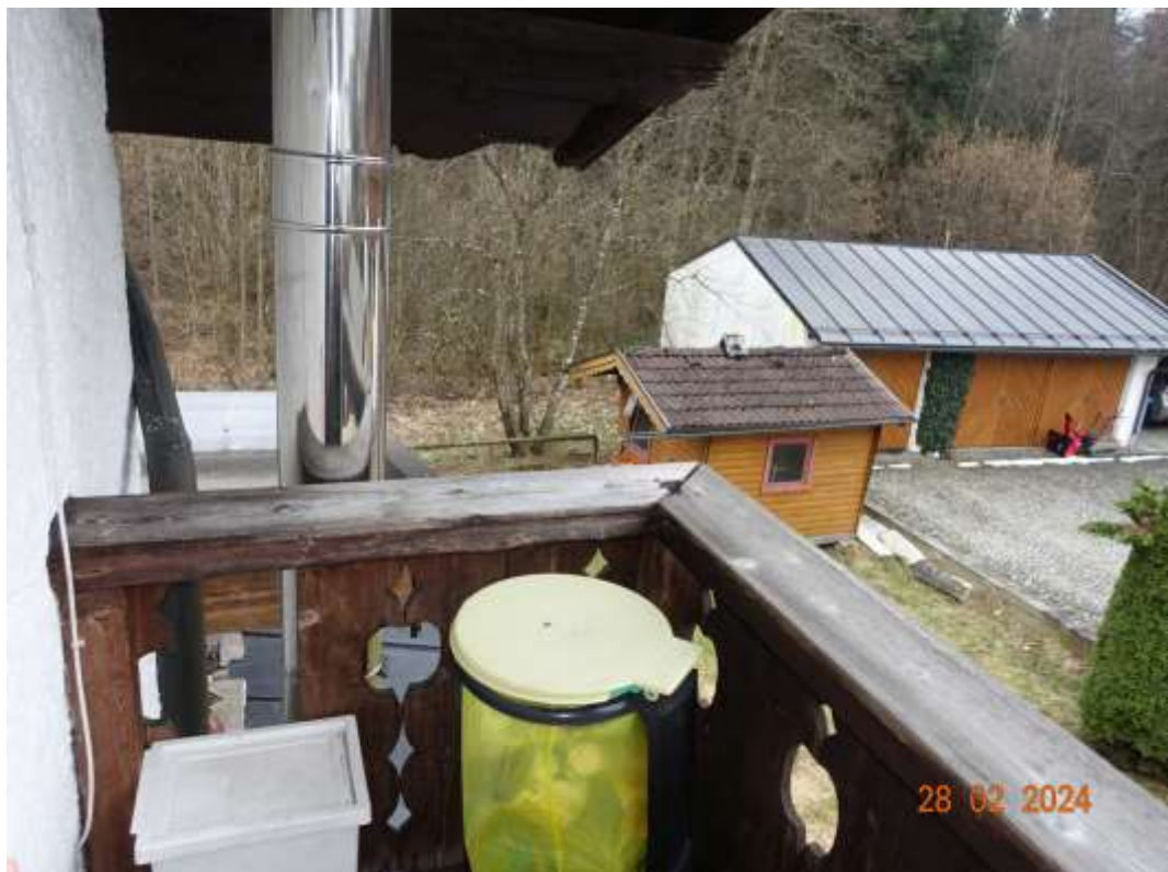
Abbildung 18: Balkon mit Edelstahlkamin für Feststoffofen im EG
