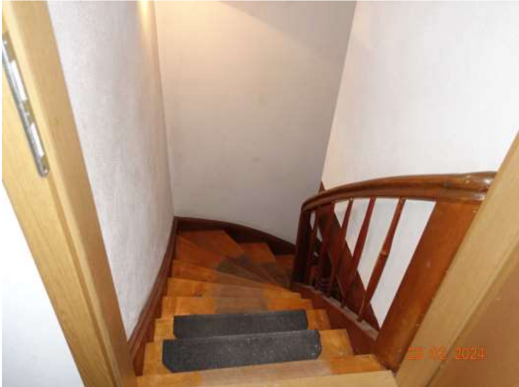
Abbildung 15: Treppenführung vom Flur im DG direkt in die Treppenführung (kein Absatz)
