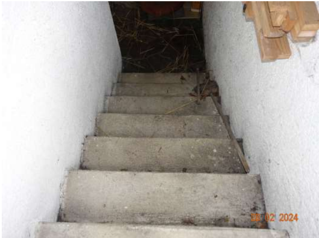
Abbildung 3: Kelleraußentreppe zur unterkellerten Terrasse
