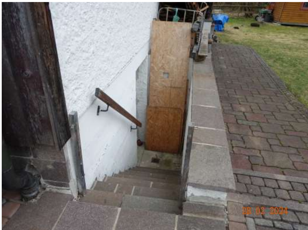
Abbildung 6: Kelleraußentreppe zum Wohnhaus
