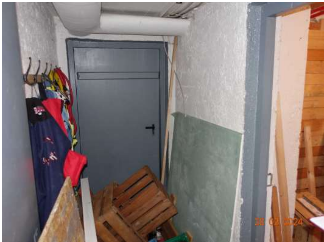
Abbildung 22: Kellerflur mit Tür zur Kelleraußentreppe
