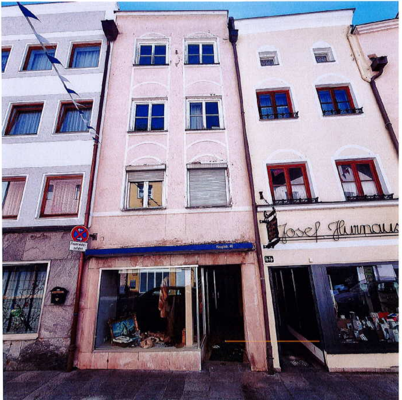
Ansicht von der Hauptstraße
