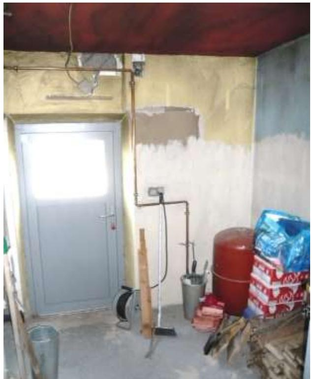
**Heizungsraum - fehlende Leitungsdämmung**
