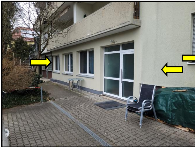
Teilansicht Gartenseite mit Lage des SOE Nr. 2 im Souterrain
