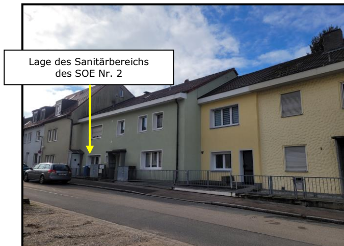
Gebäudeensemble Am Hammer 1 und 3, Ansicht Straßenseite (Ostfassade)
