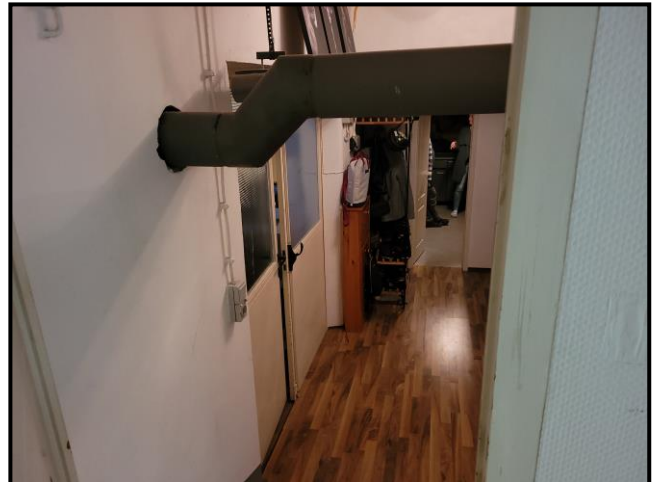
Beispiel für Innenansicht und Objektzustand: Gang mit Rauchrohr des Kaminofens
