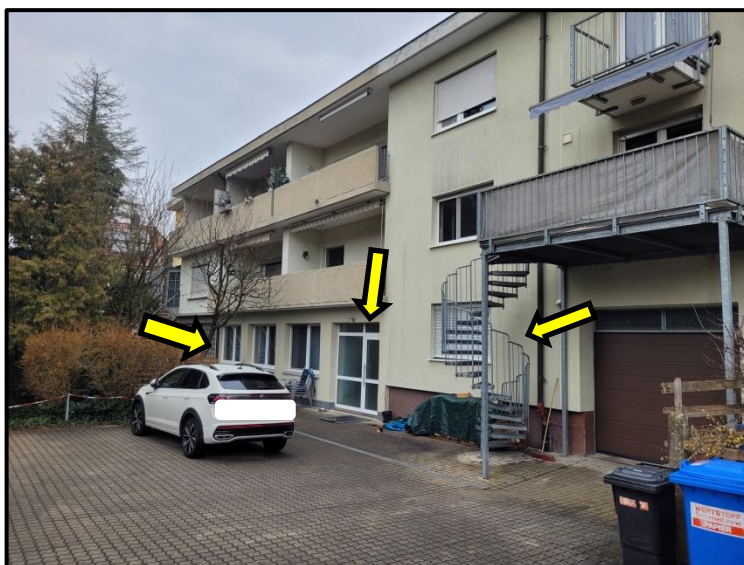
Teilansicht Hofseite (Westfassade) mit Lage des SOE Nr. 2 (Souterrain)
