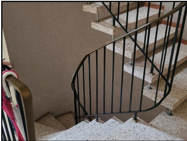
Beispiel für Innenansicht und Objektzustand: Treppenhaus im Bereich OG/DG
