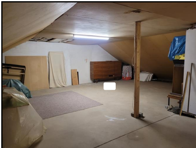
Beispiel für Innenansicht und Objektzustand: Dachboden SOE Nr. 8, ausbaubarer Teilbereich
