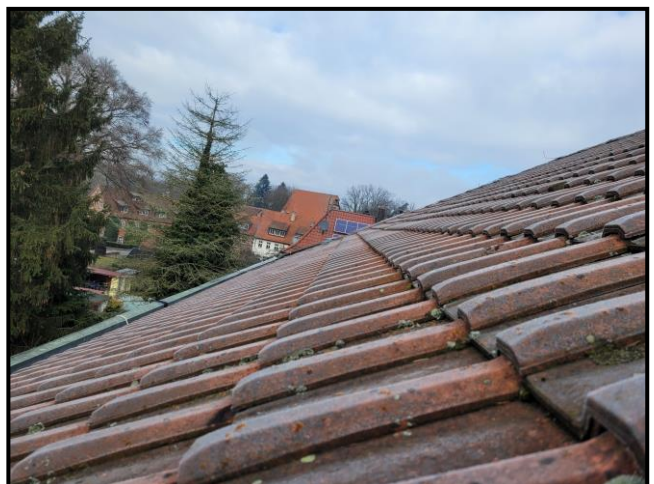
Beispiel für Objektzustand: Teilansicht westliche Dachhälfte
