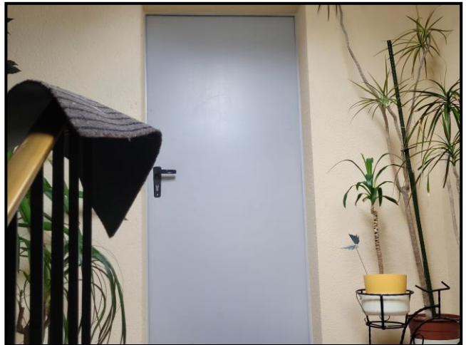
Beispiel für Innenansicht und Objektzustand: Zugang vom Treppenhaus zum Dachboden SOE Nr. 8
