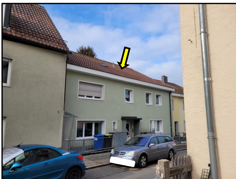
Teilansicht Straßenseite (Ostfassade) mit Lage des SOE Nr. 8
