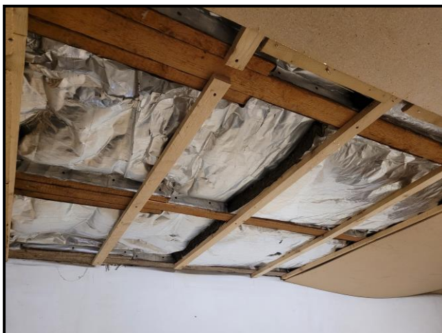
Beispiel für Innenansicht und Objektzustand: Dachboden SOE Nr. 8
