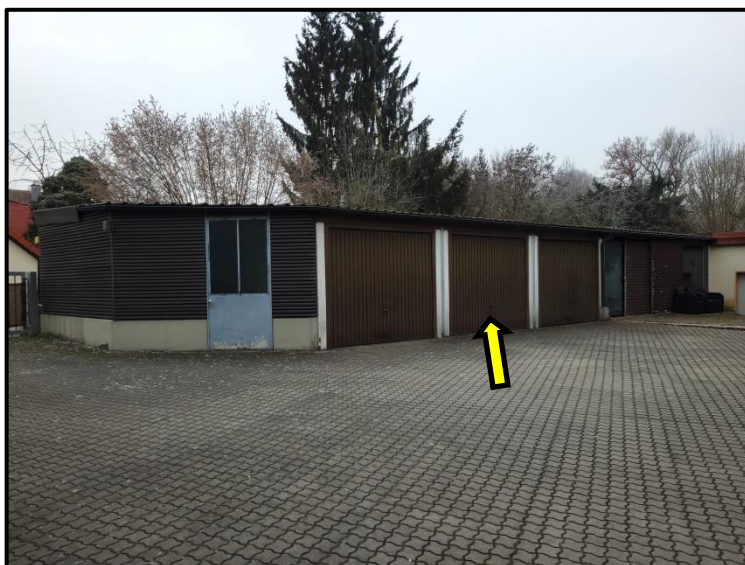
Ansicht Hofseite mit Lage der Garage SOE Nr. 10
