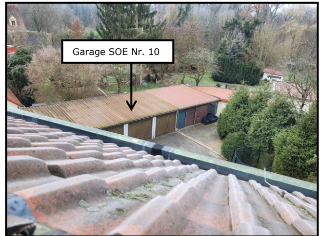
Beispiel für Objektzustand: Teilansicht Garagenzeile mit Anbauten und Hofflächen
