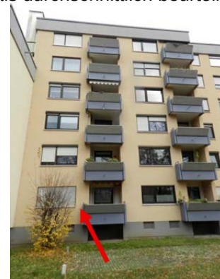
Ansicht von Westen auf Borkumer Str. 19
