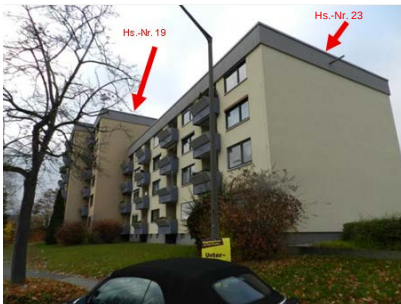
Ansicht von Südost
